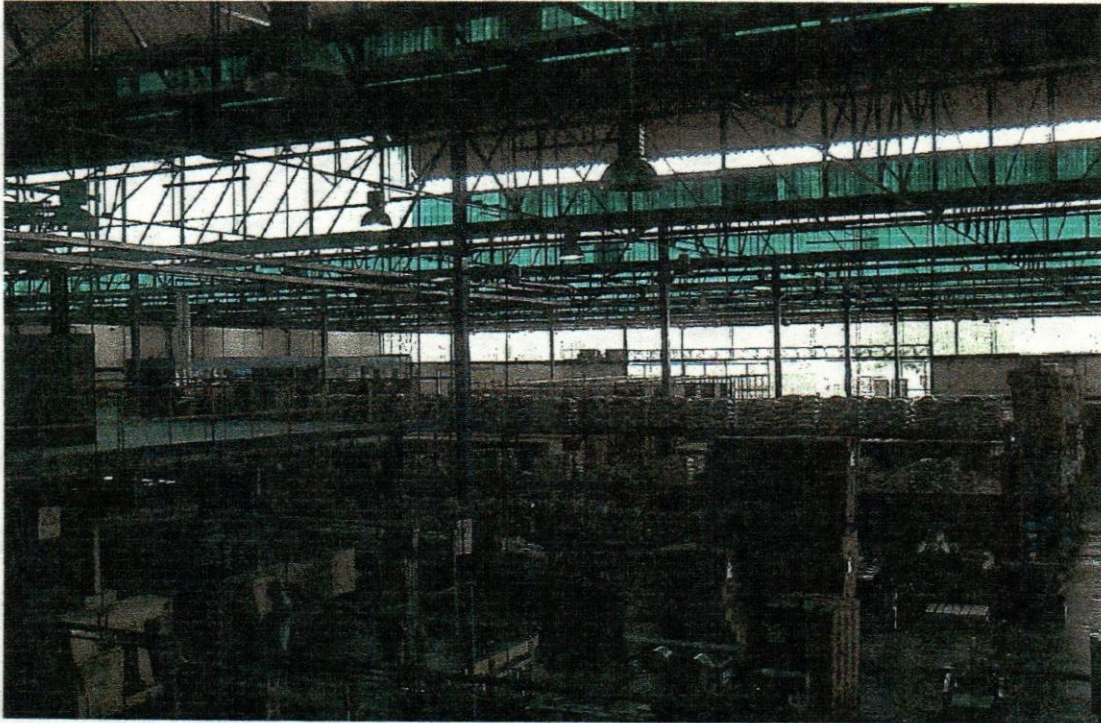
Foto #5: Almacén de producto terminado
