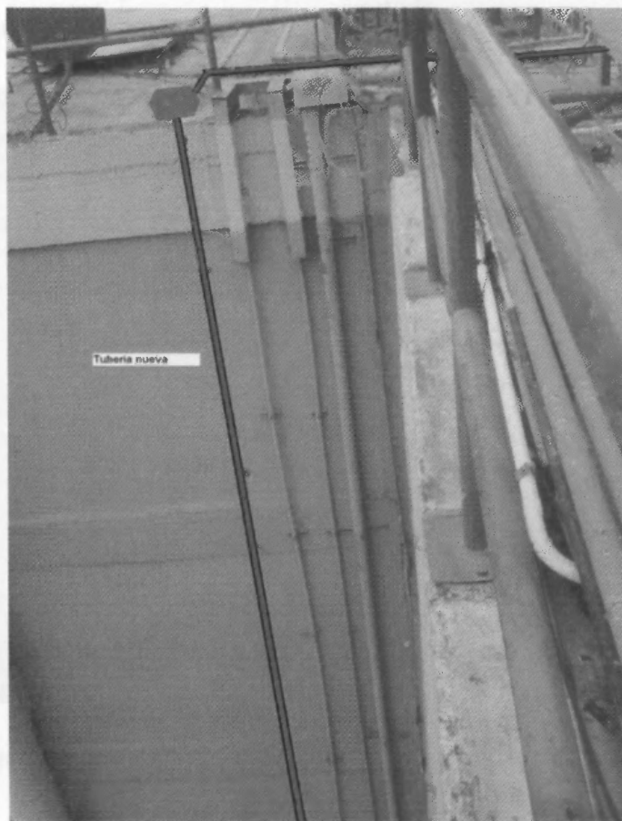
Foto 3. Detalle de la caja de paso que recibe a la fibra.
