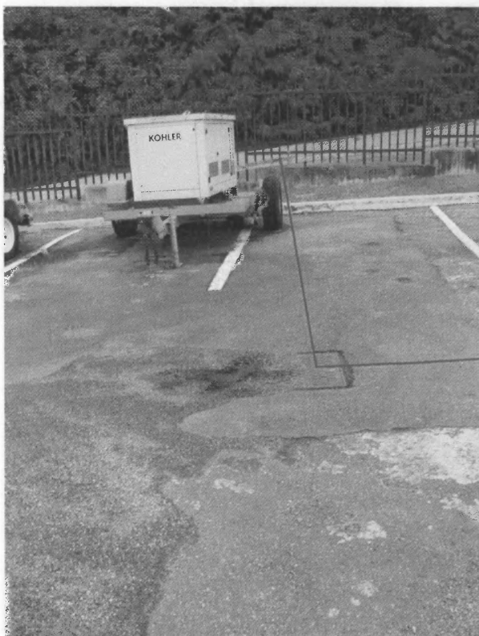
Foto 3. Detalle de la ruta de la tubería proveniente de la calle.
