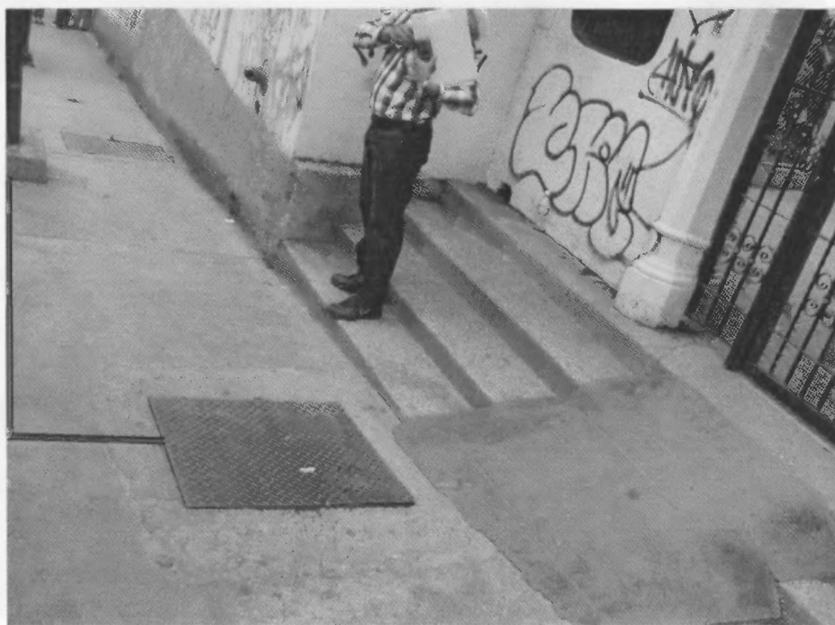
Foto 2. Tanquilla No 1 donde debe llegar la bancada de 1x2" de diámetro.
