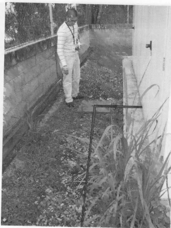
Foto 4. Acceso al shelter a través de la tubería eléctrica.
