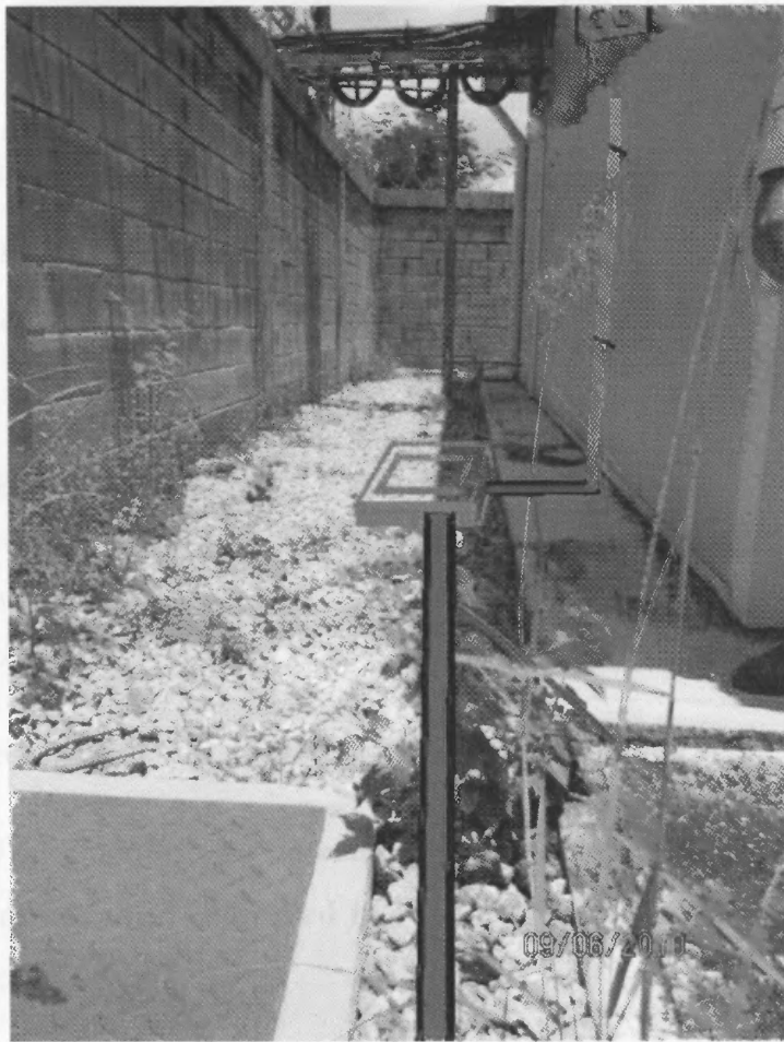
Foto 2. Nueva tanquilla y ductos
