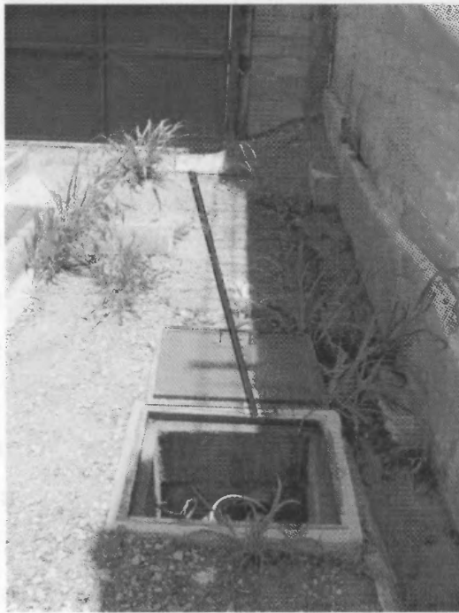
Foto 4. Tanquilla No 2 como se puede observar no tiene tapa.
