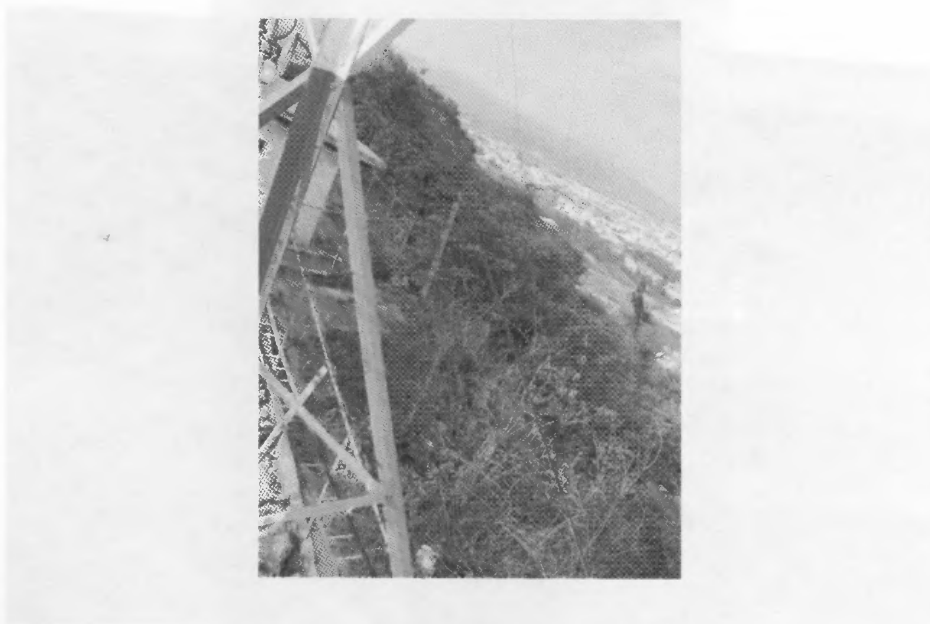
Foto 4. Poste número 2 inexistente a colocar.
