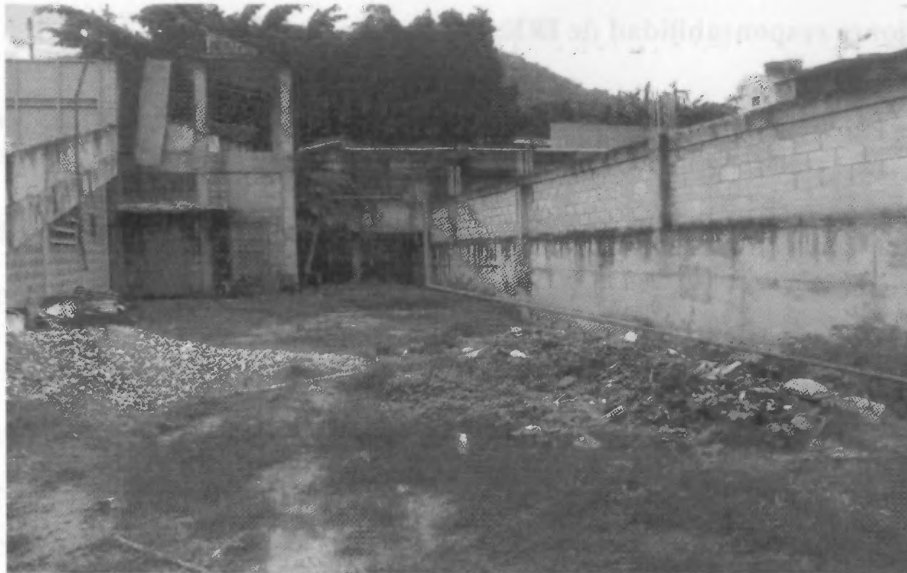
Foto 2. Ruta donde será colocada la tubería de 1" y media.
