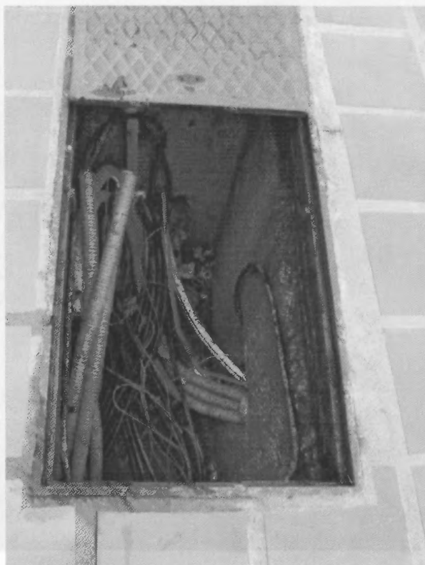
Foto 7. Recorrido de la fibra a través de la ductería.
