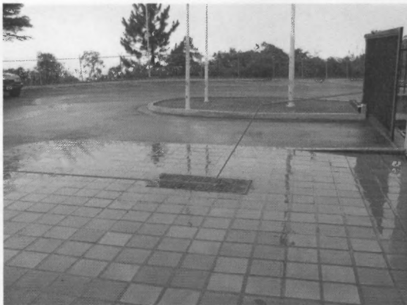
Foto 6. Recorrido de la tubería.
