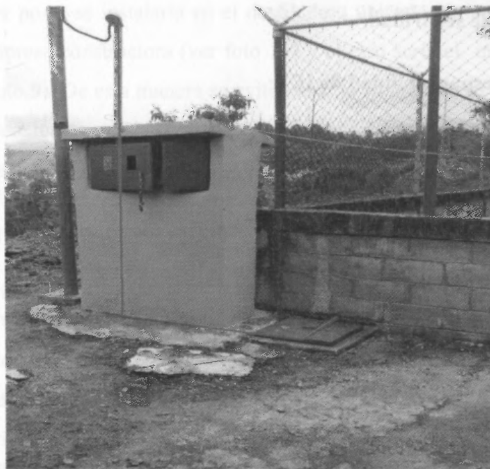
Foto 1. Paso a través de la caja del tablero eléctrico.
