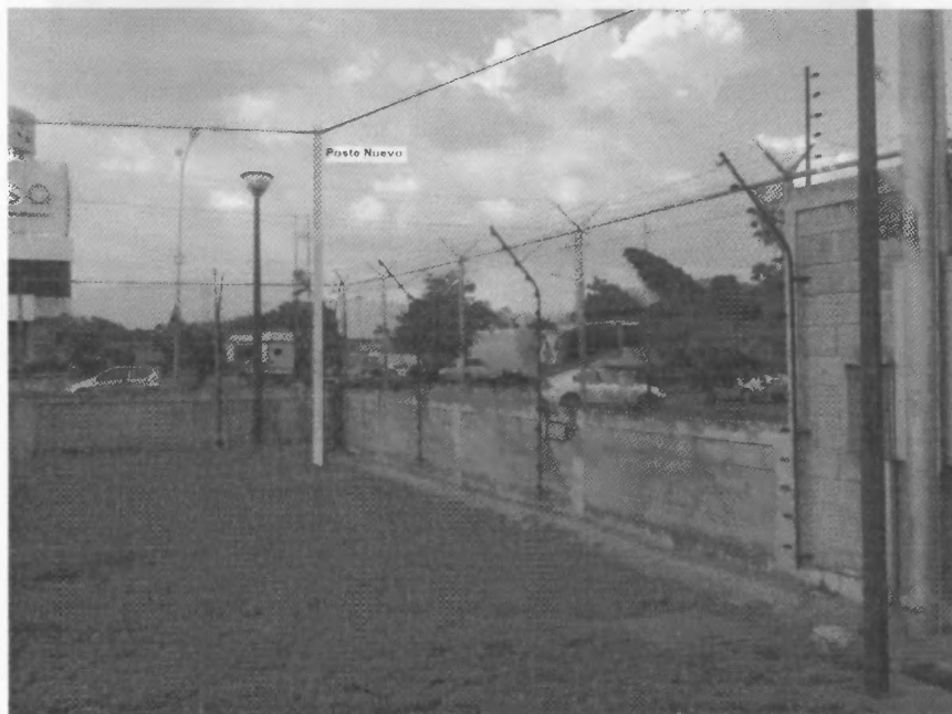
Foto 1. Instalación de postes nuevos inexistentes.
