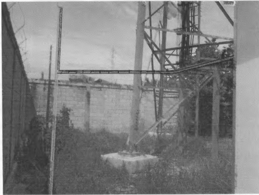
Foto 2. Poste nuevo no existente y detalle de escalerilla para ingresar al shelter.
