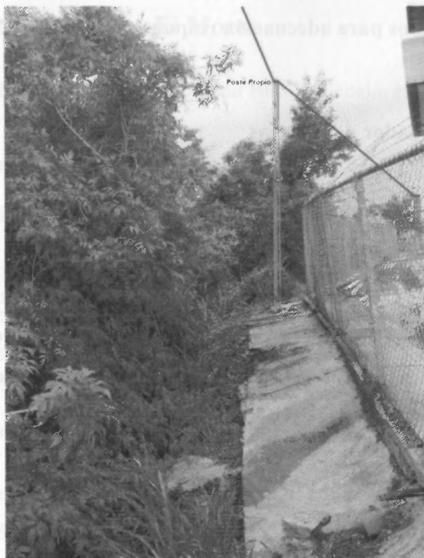
Foto 2. Postes inexistentes a colocar.
