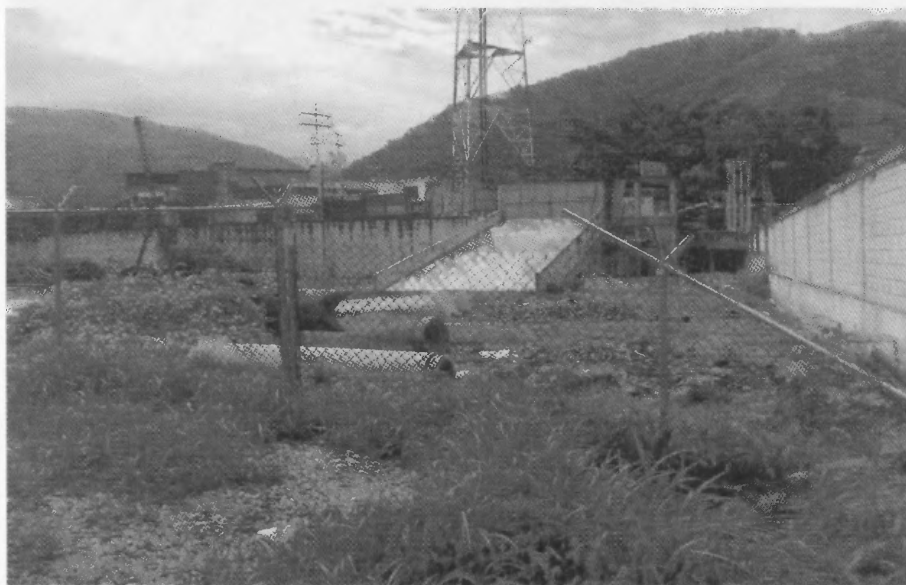
Foto 1. En el Puente se colocara el poste de 15 metros.
