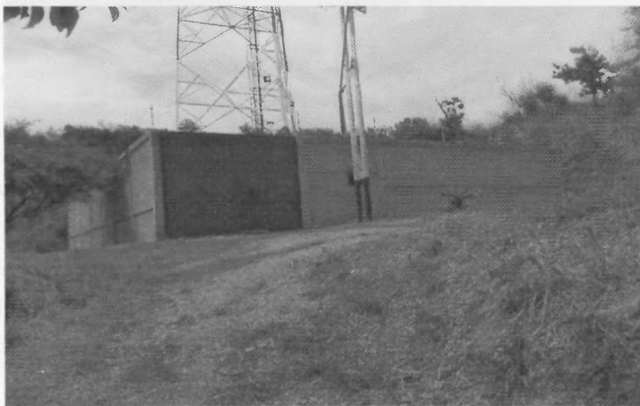
Foto 1. Poste de alta tensión frente a estación
