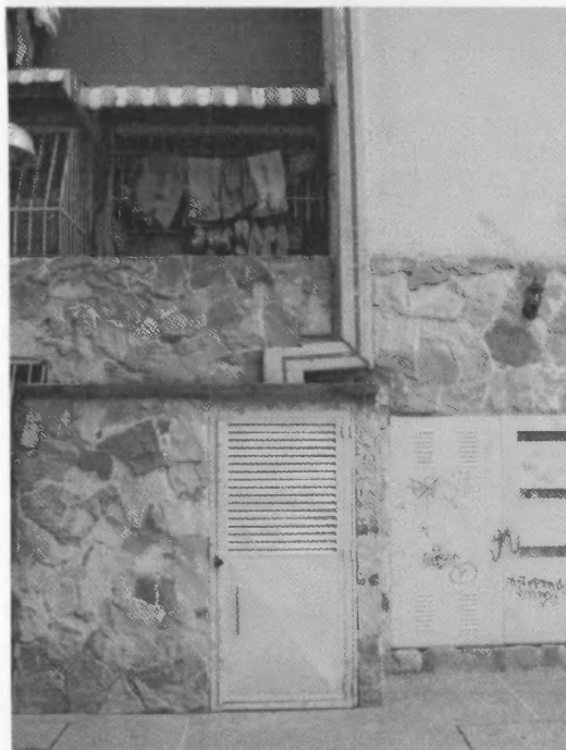
Foto 7. Caseta y canalización existente
