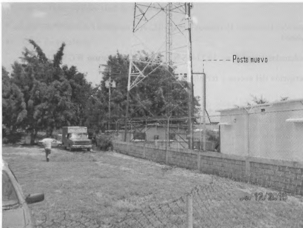
Foto 2. Ubicación del nuevo poste
