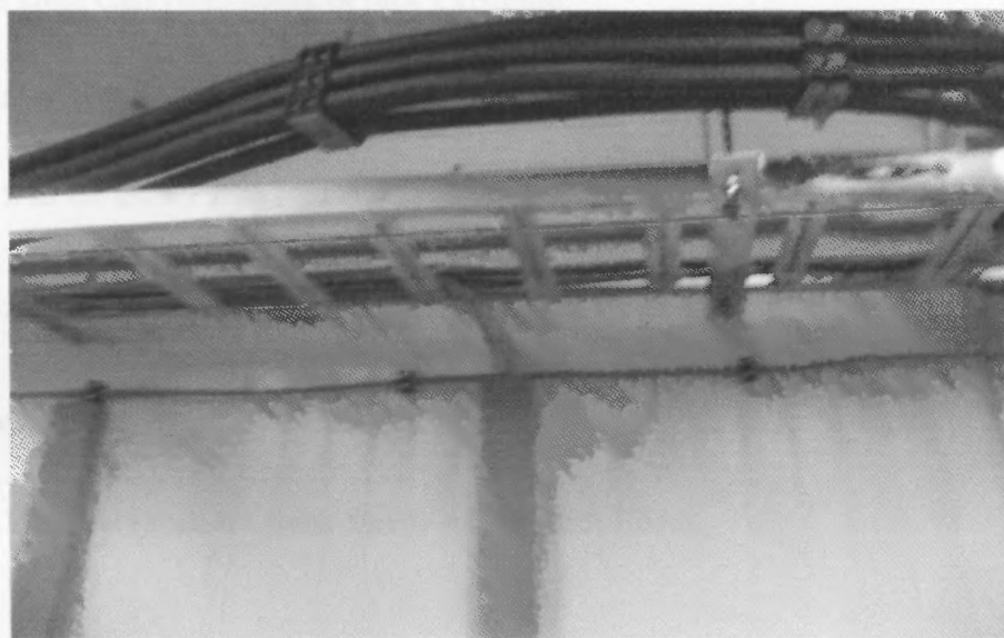
Foto 2. Tendido de la fibra por la escalerilla existente hacia el gabinete.
