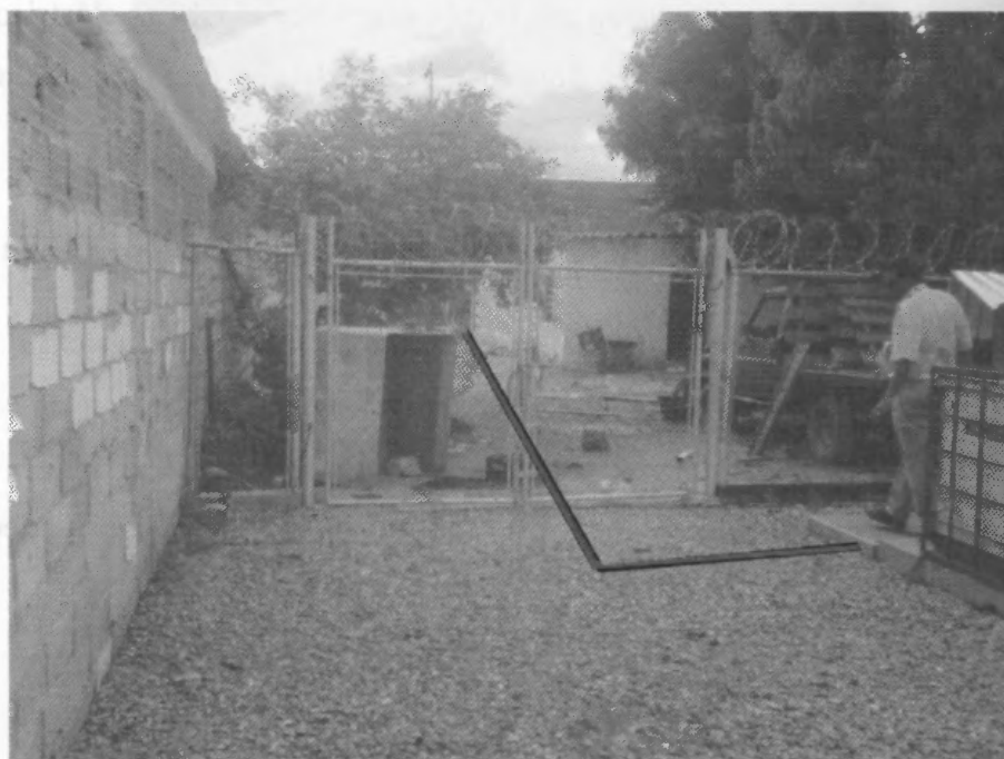
Foto 1. Tubería existente perteneciente a IFX Networks.
