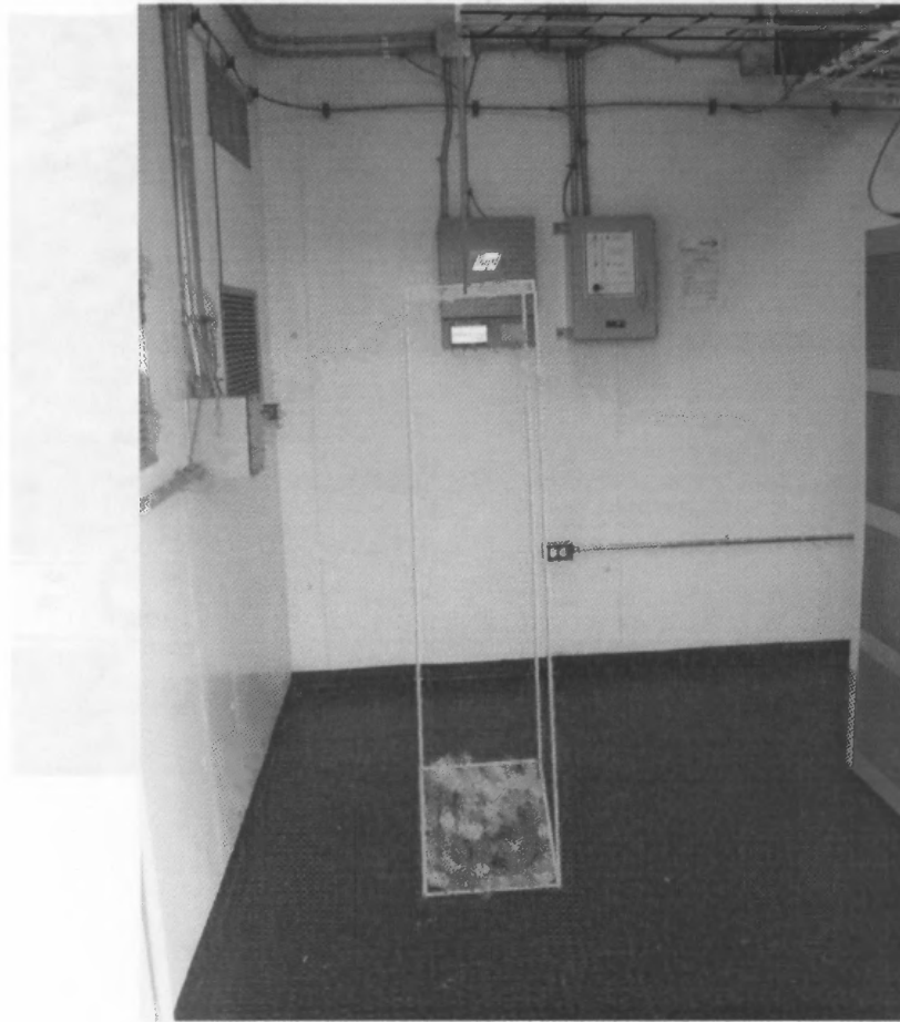
Foto 7. Llegada al rack a través de escalerilla nueva.
