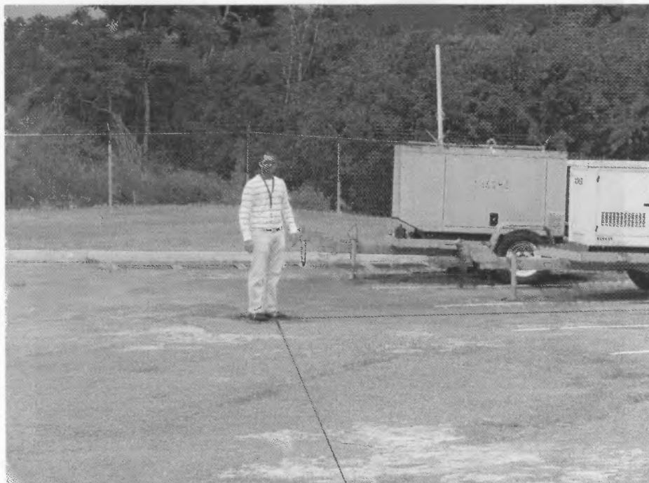
Foto 4. Detalle del recorrido de la tubería.
