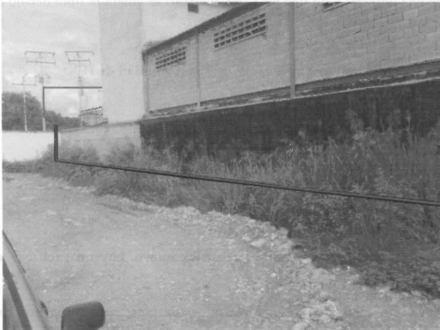
Foto 1. Recorrido de la tubería eléctrica existente a utilizar.
