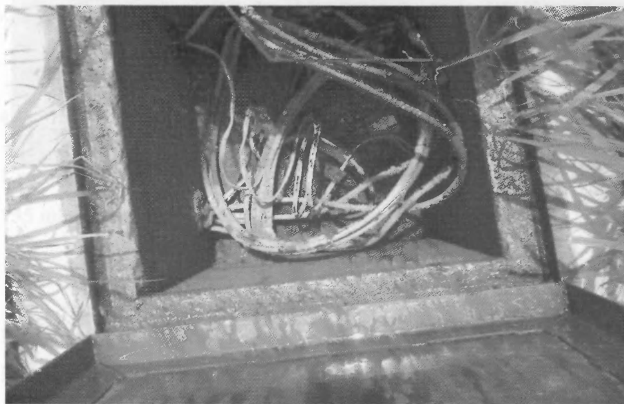
Foto 3. Paso de la fibra en la tanquilla hacia el shelter.
