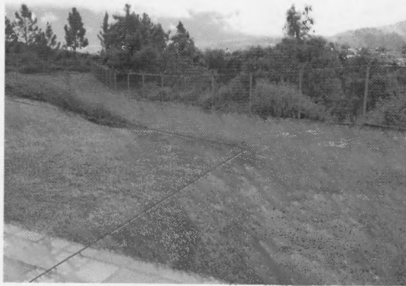
Foto 8. Recorrido de la tubería.
