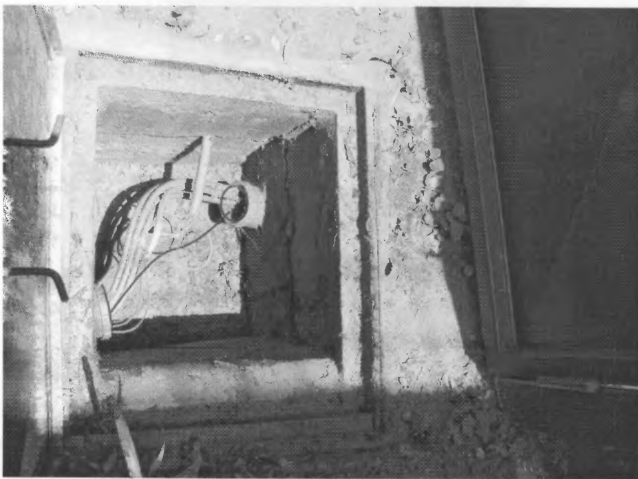
Foto 3. Tanquilla No 1. Detalle de ruta de la fibra.
