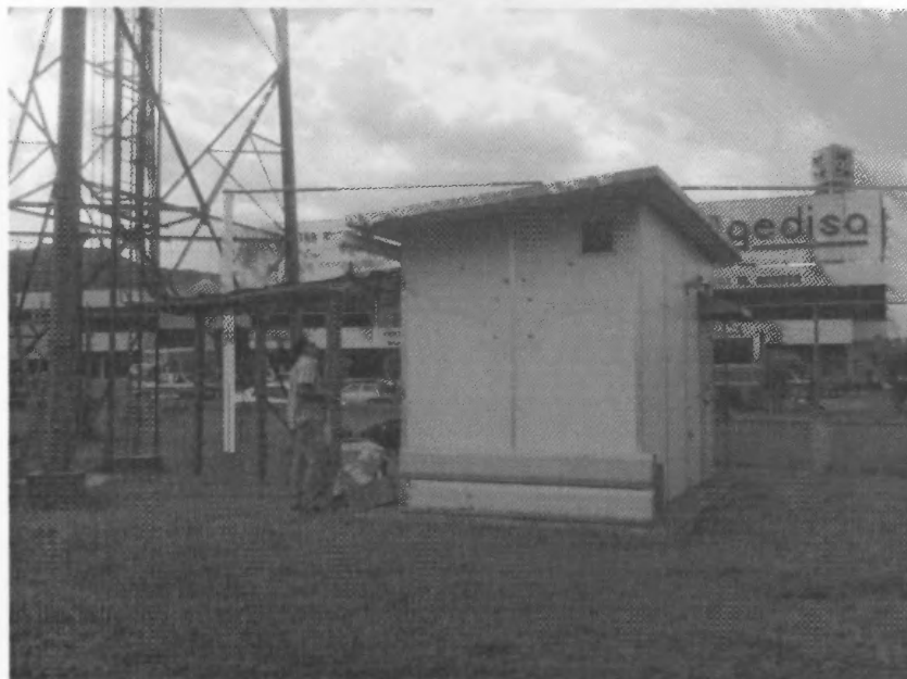
Foto 2. Instalación del segundo poste nuevo inexistente.
