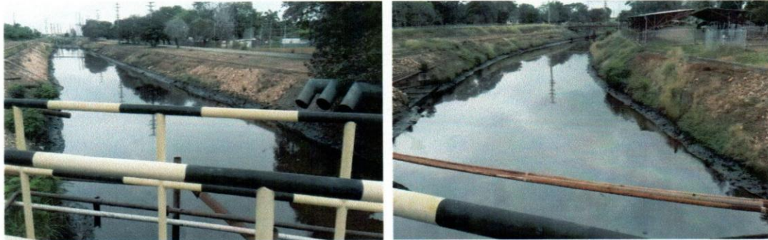
Figura 25. Canal de aguas de lluvia. En la imagen de la izquierda se muestra el canal aguas arriba del puente. Se observa en la misma imagen tres tuberías azules las cuales descargas aguas contaminadas con hidrocarburos al canal. En la imagen de la derecha se muestra el canal aguas abajo del puente. Nota: Datos tomados del autor (2014).
