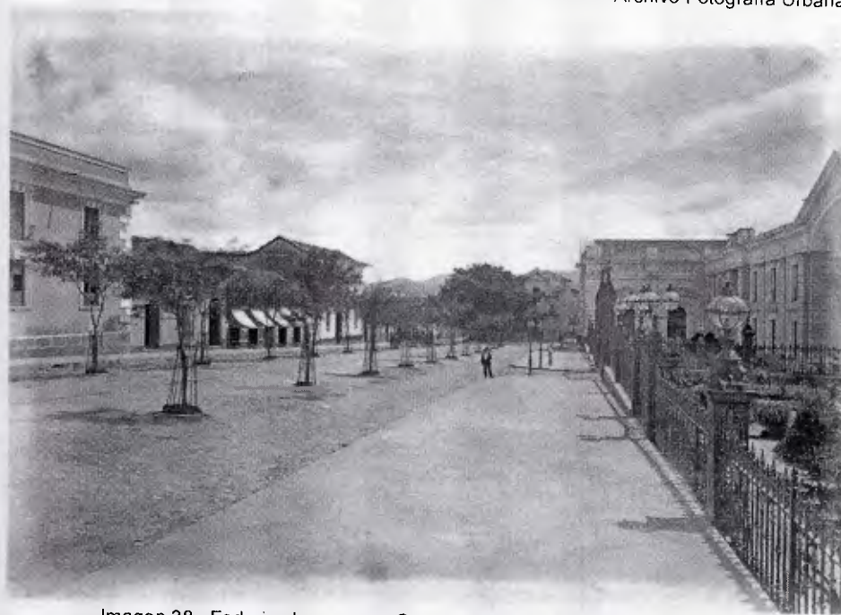
Imagen 38. Federico Lessmann, Caracas. Avenida Este Palacio Federal . Circa 1877. Archivo Fotografía Urbana
