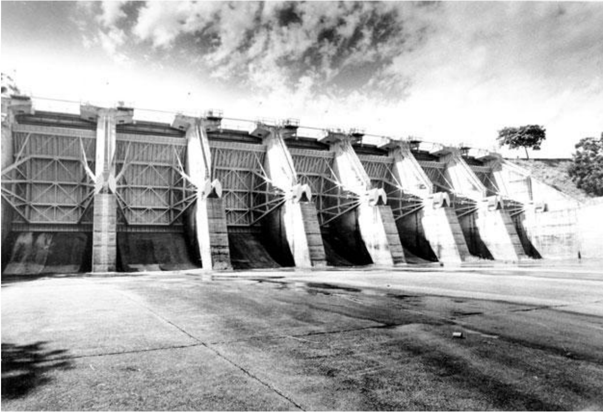
Planta hidroeléctrica de Tres Marias.
