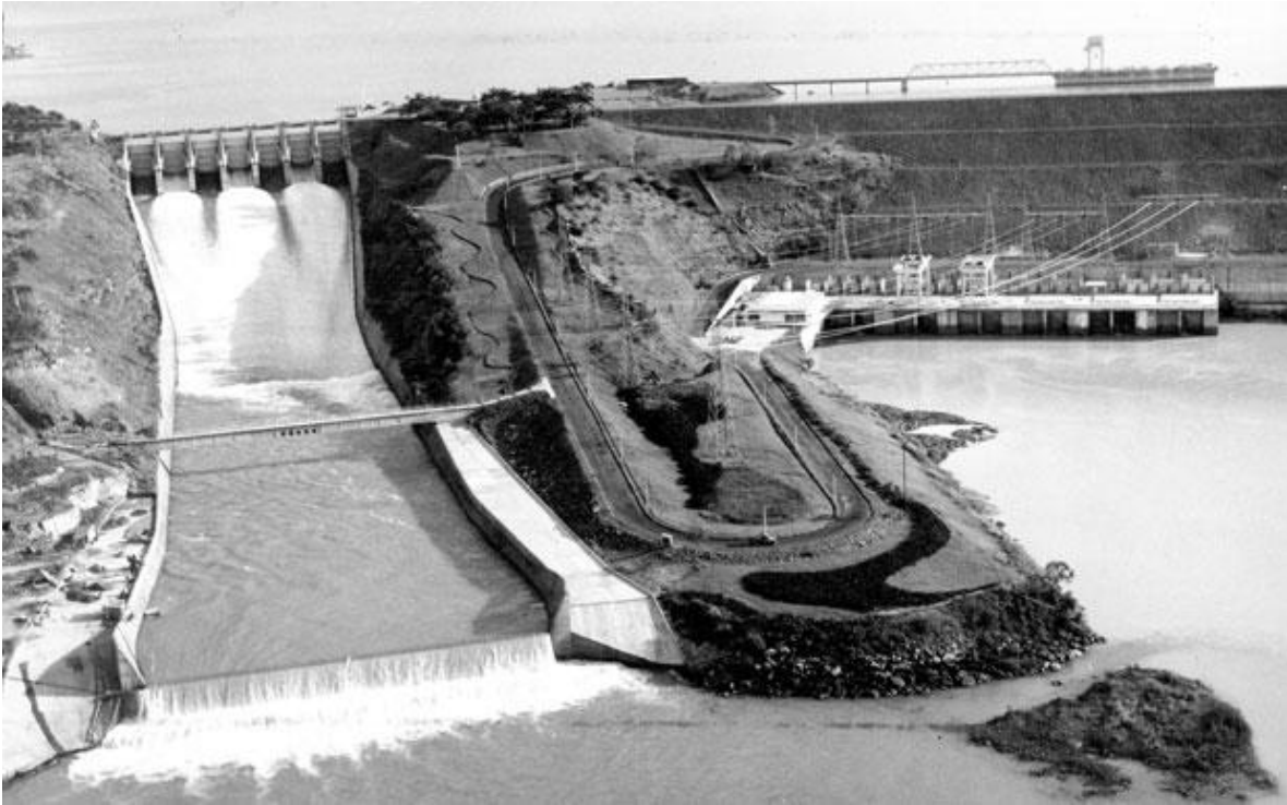
Otra vista de la planta hidroeléctrica de Tres Marias.
