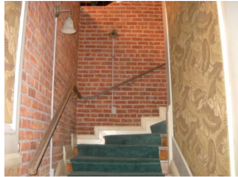
Ejemplo de las escaleras del edificio
