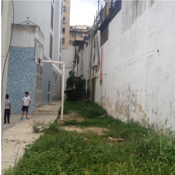
Anexo N°52: Jardinera 3, parte trasera. Fuente propia. Fecha 20 de Abril del 2016
