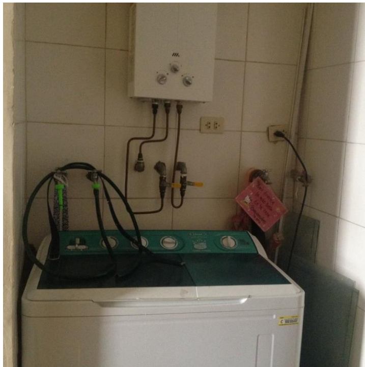
Anexo N°19: Lavadero. Fuente propia. Fecha 6 de Abril del 2016
