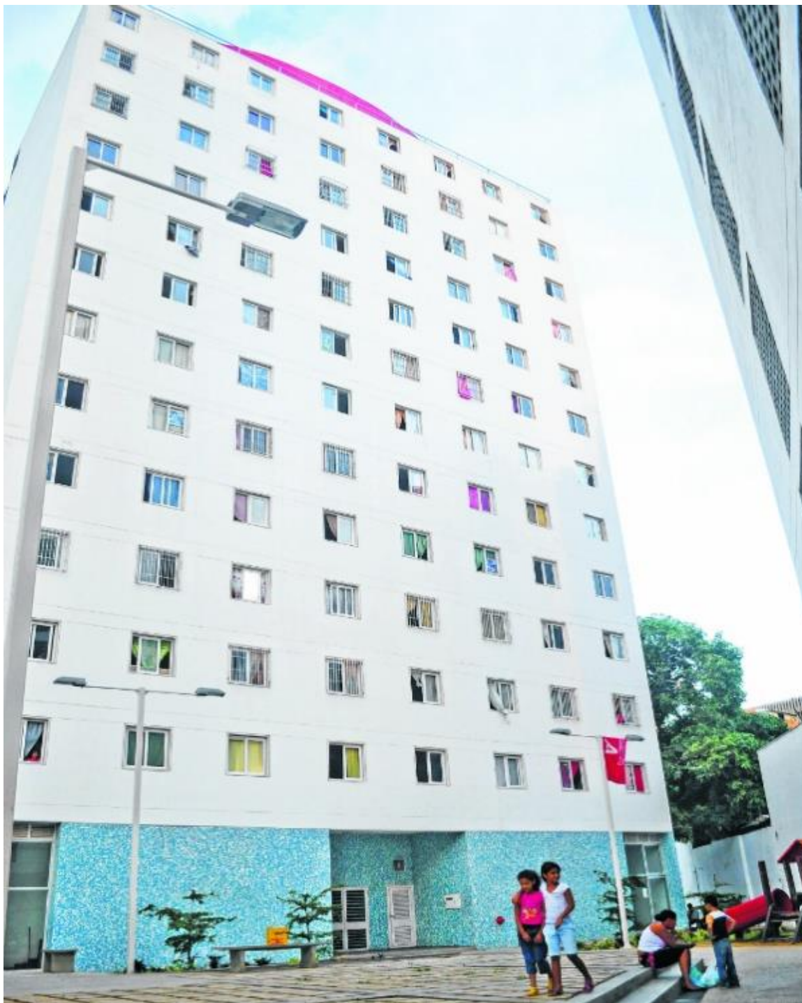
Anexo N°13: Vista de Oeste de la fachada. Fuente: www.correodelorinoco.gob.ve
