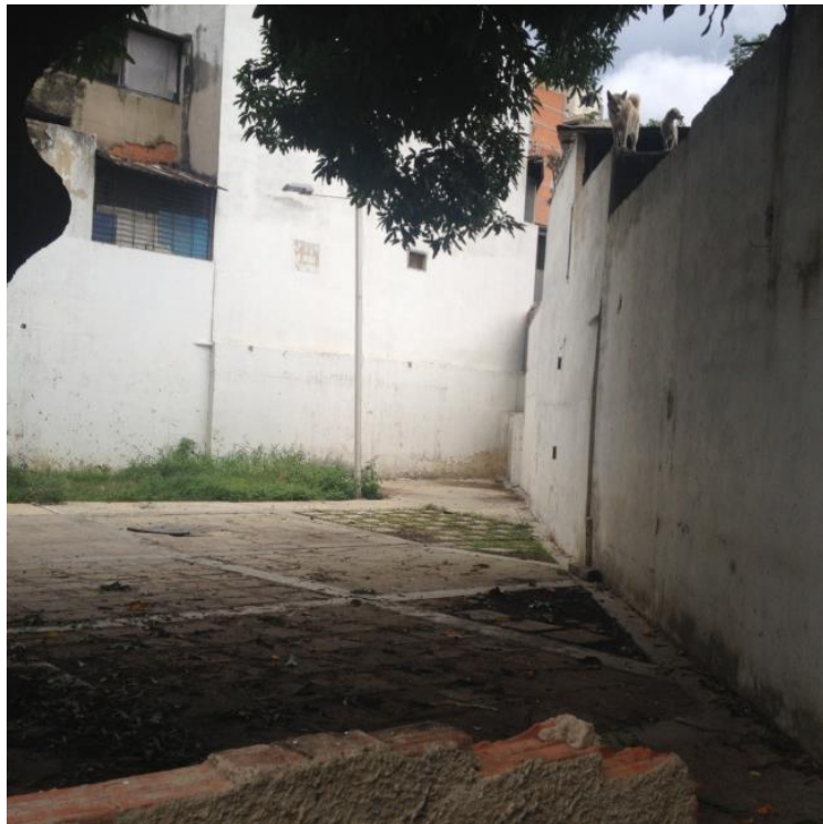
Anexo N°49: Parte trasera PB. Fuente propia. Fecha 20 de Abril del 2016
