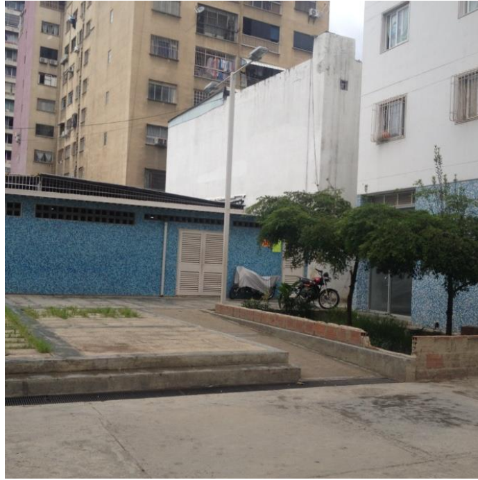
Anexo N°46: Vista Norte parte de enfrente PB. Fuente propia. Fecha 20 de Abril del 2016
