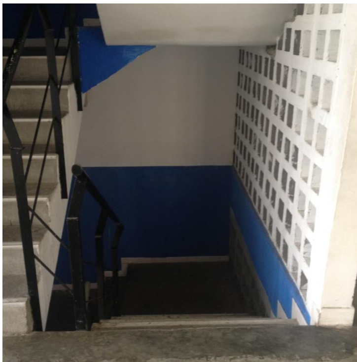
Anexo N°28: Escaleras. Fuente propia. Fecha 6 de Abril del 2016
