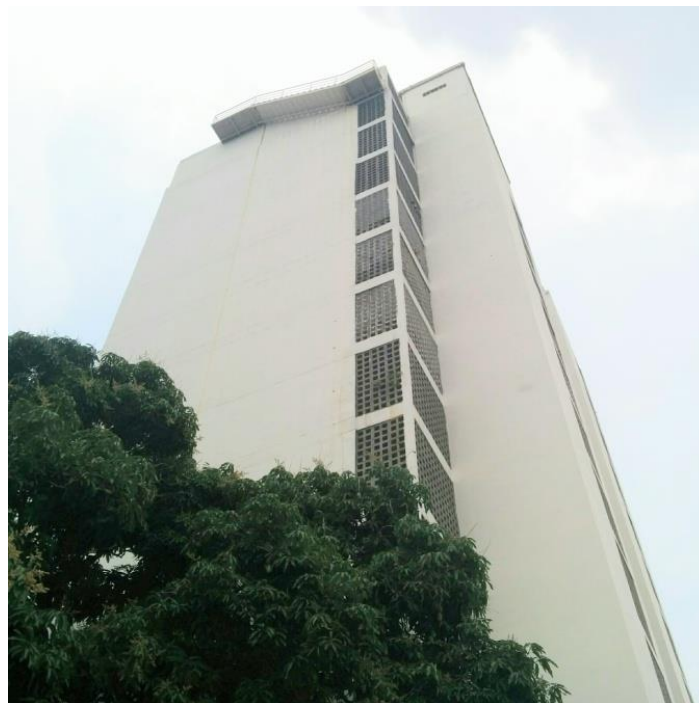
Anexo N°15: Vista Sur-Este de la Fachada. Fuente propia. Fecha 20 de Abril del 2016
