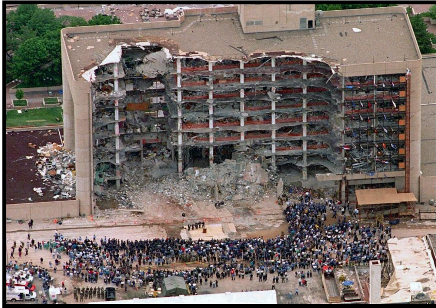
Figura II-10: Edificio Murrah Federal Building luego de la explosión
