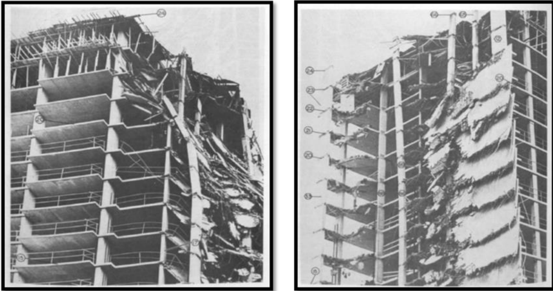
Figura II-8: Vistas de la parte este y oeste del edificio después del colapso.
