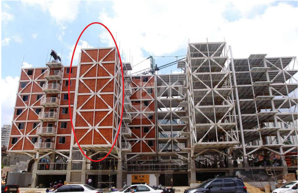
Arriostramientos. Perfil tubular 200 mm
