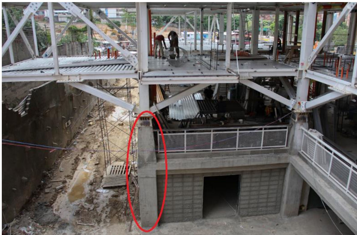
Columna de concreto armado
