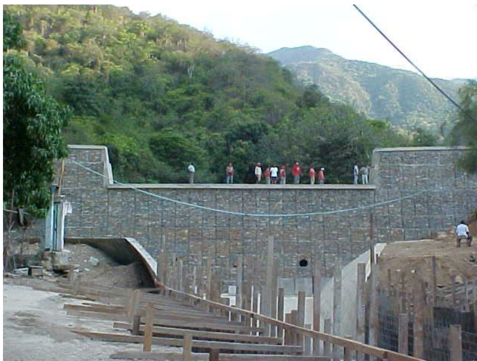
Figura A. 20 - Vista frontal hacia aguas arriba de la Presa Cerrada en la Qda. La Zorra
