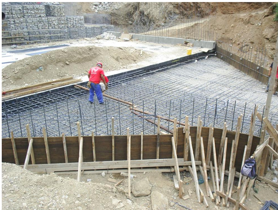
Figura A. 18 - Proceso constructivo de la embocadura de la Presa Cerrada en la Qda. La Zorra
