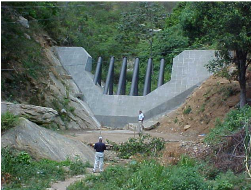
Figura A. 14 - Vista frontal hacia aguas arriba de la Presa Abierta tipo Rastrillo en el afluente "B" de la Qda. Tacagua
