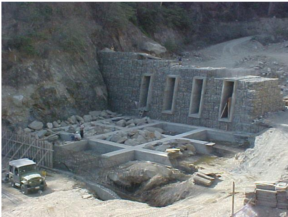
Figura A. 2 - Presa Abierta de Ventanas de Camuri Chico en construcción
