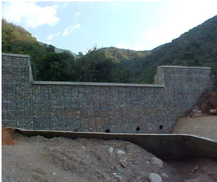
Figura 68. Presa cerrada de gaviones en la Qda. La Zorra
