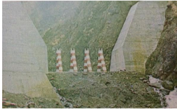
Figura 63. Presa de rastrillo en Japón
