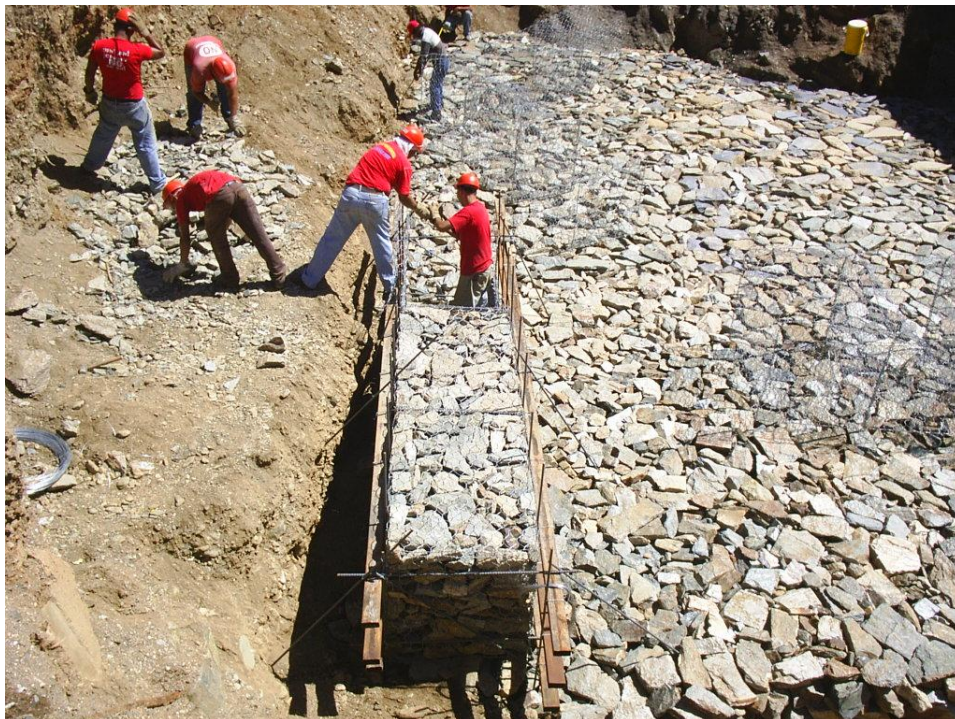
Figura A. 16 – Construcción de gaviones para la Presa Cerrada en Qda. La Zorra.
