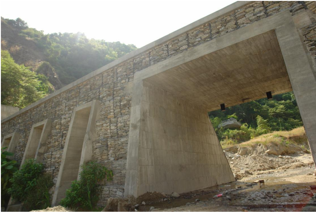
Figura A. 3 - Vista frontal hacia aguas arriba de la Presa Abierta de Camuri Chico donde se aprecia el cajón central de acceso y las ventanas
