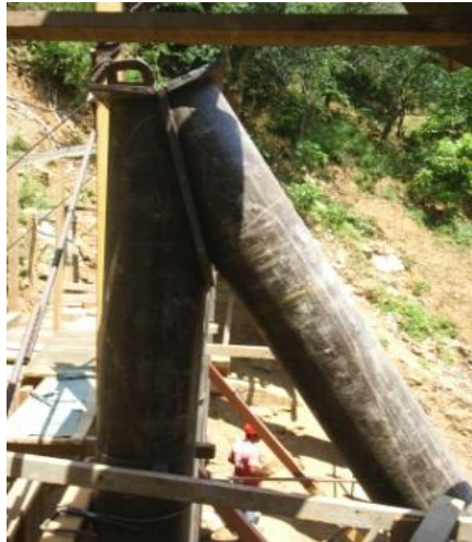
Figura 67. Unión de tubo vertical con tubo inclinado
