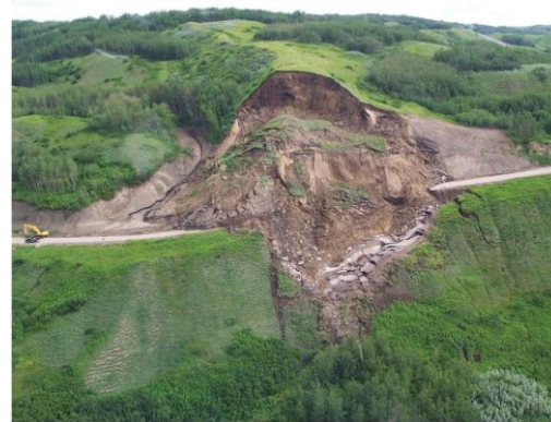
Figura 23. Fotografía de un deslizamiento traslacional ocurrido en el 2001 en Columbia Británica, Canadá
