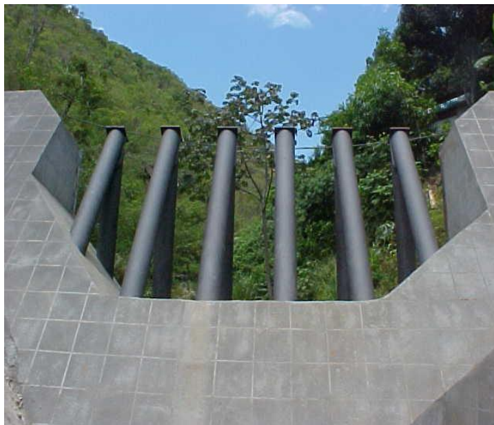
Figura 66. Presa Abierta tipo rastrillo en el afluente "B" de la Qda. Tacagua
