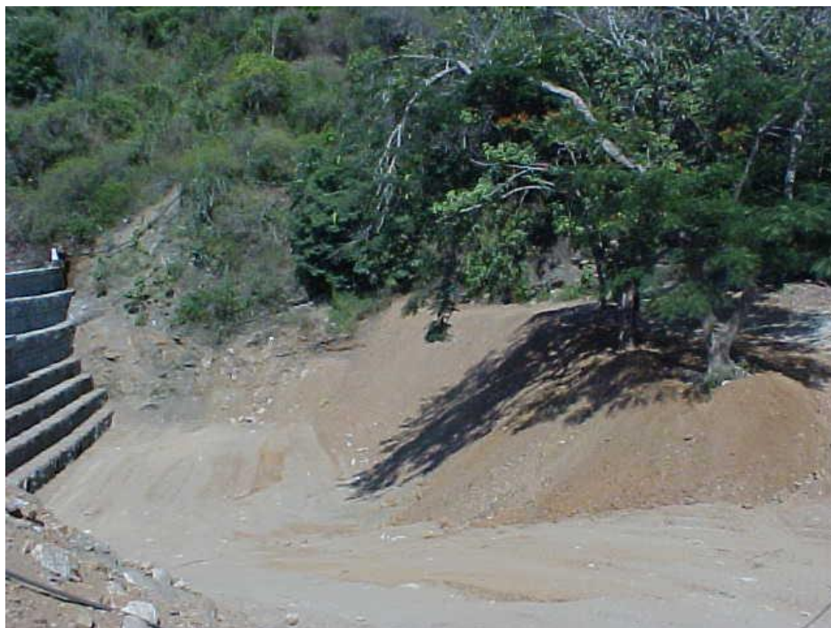
Figura A. 19 - Vaso de almacenamiento de la Presa Cerrada en la Qda. La Zorra
