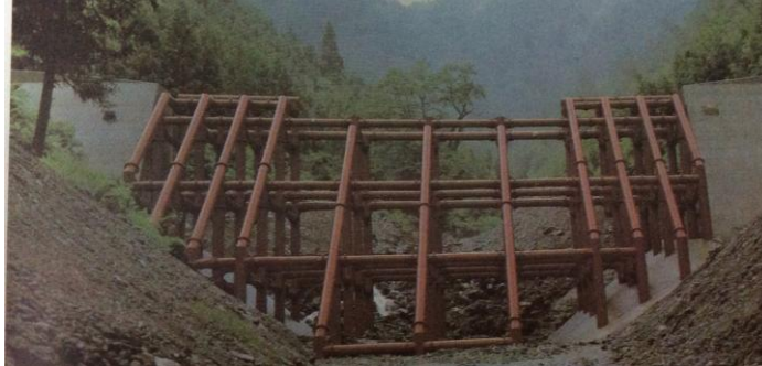
Figura 61. Presa de enrejado reticular en Japón Referencia: (62)
