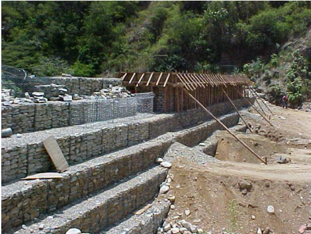
Figura A. 17 - Proceso constructivo Presa Cerrada en Qda. La Zorra
