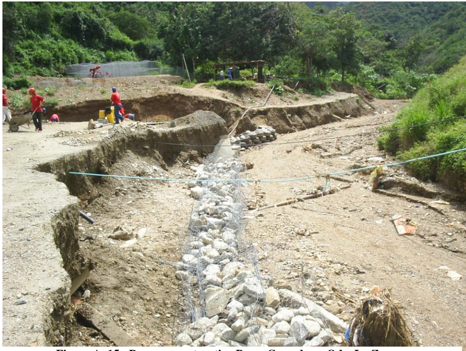
Figura A. 15 - Proceso constructivo Presa Cerrada en Qda. La Zorra
