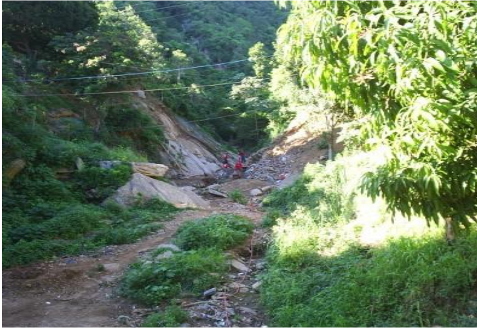
Figura A. 9 - Proceso constructivo de la Presa Abierta tipo Rastrillo en el afluente "B" de la Qda. Tacagua, se observa que el sitio de presa es en una zona angosta del cauce
