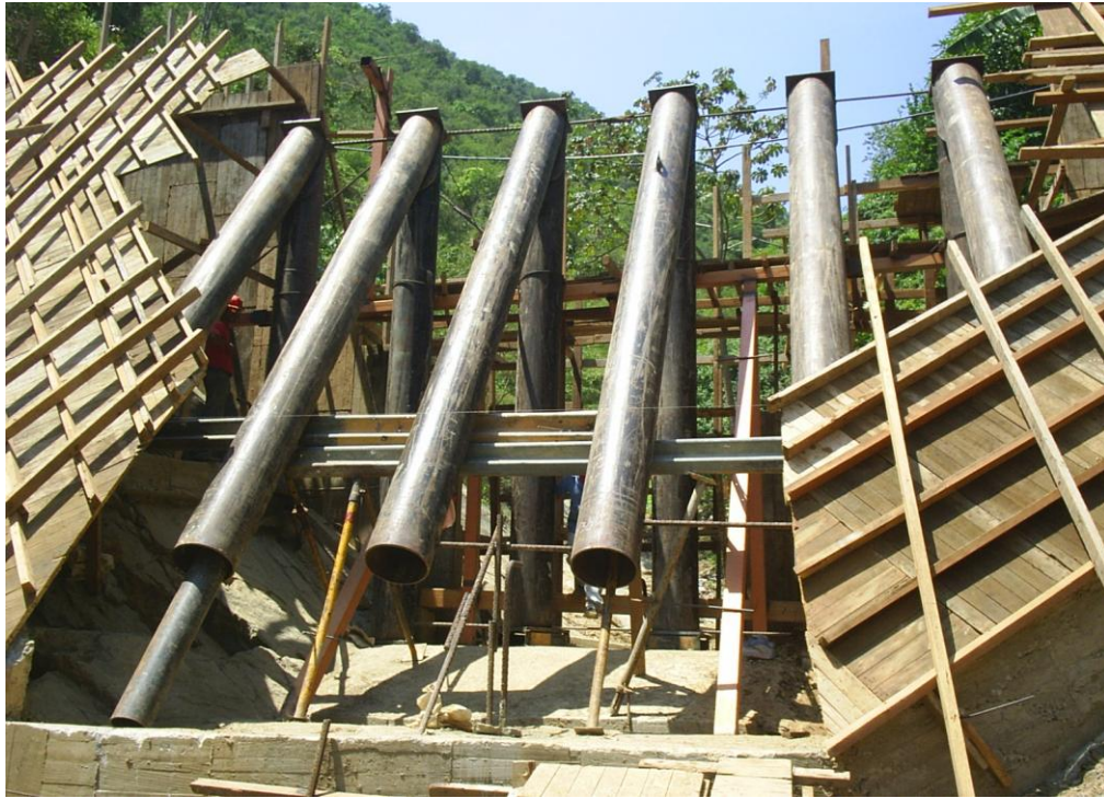
Figura A. 13 - Proceso constructivo de la Presa Abierta tipo Rastrillo en el afluente "B" de la Qda Tacagua
