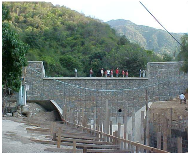
Figura 69. Presa de retención en Qda. La Zorra
