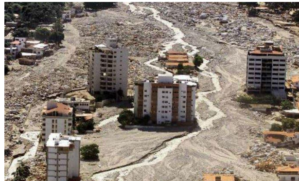
Figura 54. Vista aerea de daños causados por el evento de flujo de detritos
