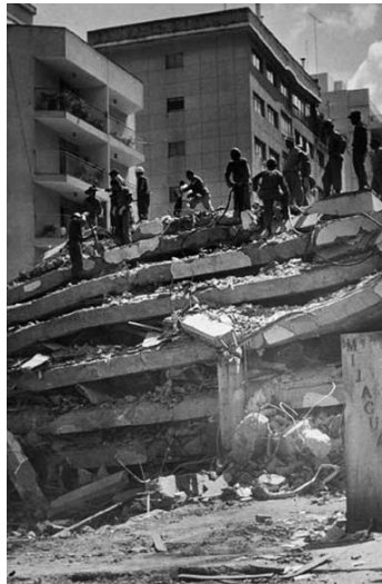
Figura II-11. Edificio Mijagual luego del sismo ocurrido en 1967 en Caracas. Tomada de http://encontrarte.aporrea.org/imagenes/Efemerides/terremoto1967.jpg
