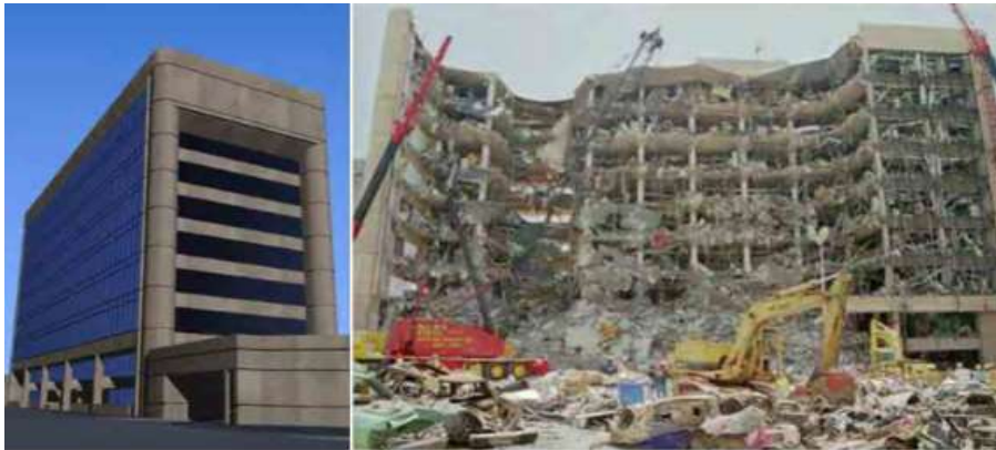
Figura II-4. Edificio Federal A. P. Murrah antes y después de la detonación del camión bomba. Tomada de, “Colapso Progresivo de Edificios De Concreto”. Barbosa, R., 2013.
