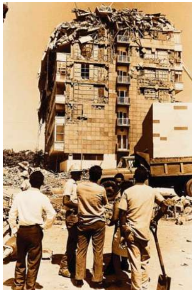
Figura II-13. Mansión Charaima luego del sismo. Tomada de http://jfbblueplanet.blogspot.com/2014/04/los-5-sismos-de-caracas.html
