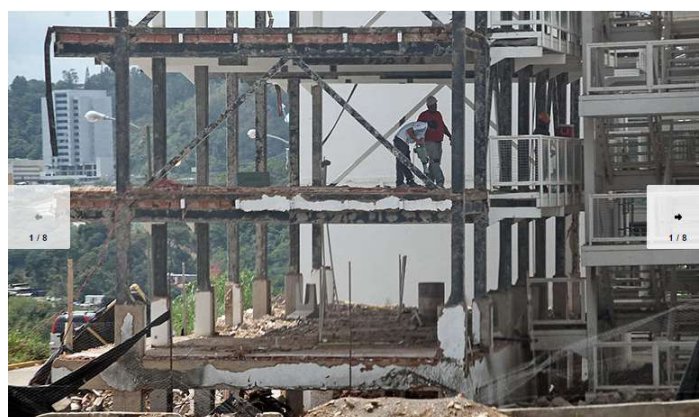
Figura II-6. Bloque número 5 de la terraza 10 de Pablo VI en demolición. Tomada de “Por Peligro de Colapso Derriban Edificio De La Misión Vivienda”. El Nacional: Gran Caracas. 2013.
