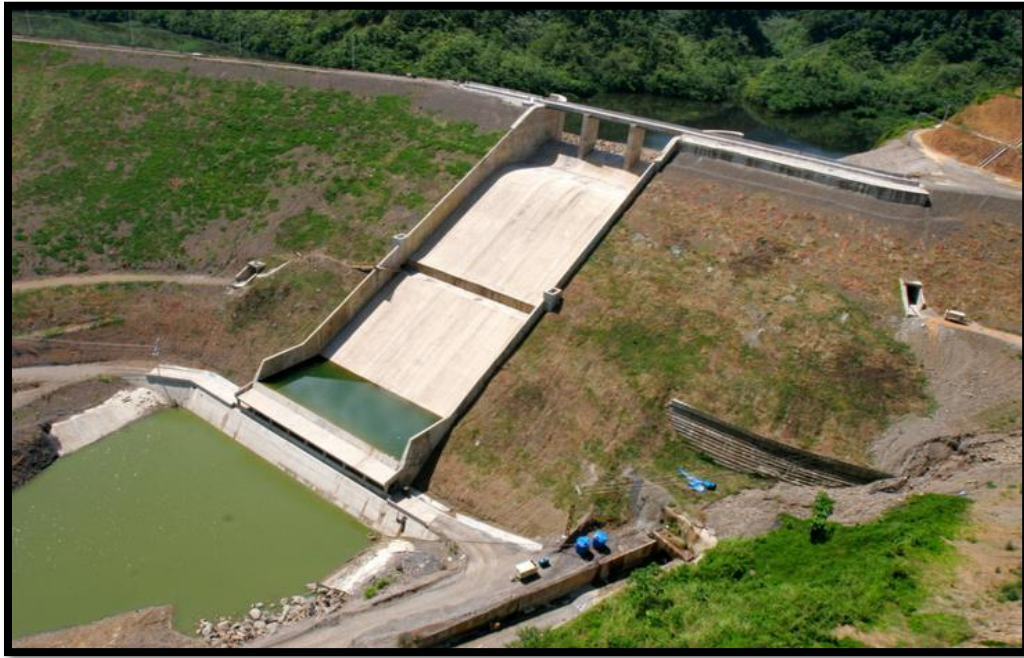
Figura 2.9- Reconstrucción de Presa El Guapo con RCC (2007). Fuente: http://hernandezfoto.zenfolio.com/p262298640/h640A001D#h653ead36
