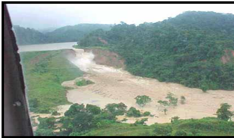
Figura 2.7- Falla del aliviadero de La Presa de Tierra El Guapo (1999).
