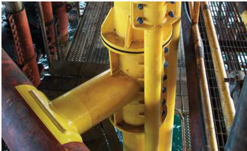
Figura 2. 2: Ejemplo de tubería ascendente unida a una plataforma. Fuente: Aquaterra Energy
