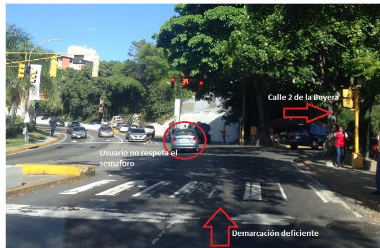
Figura 13: Estado de la demarcación y señalización
