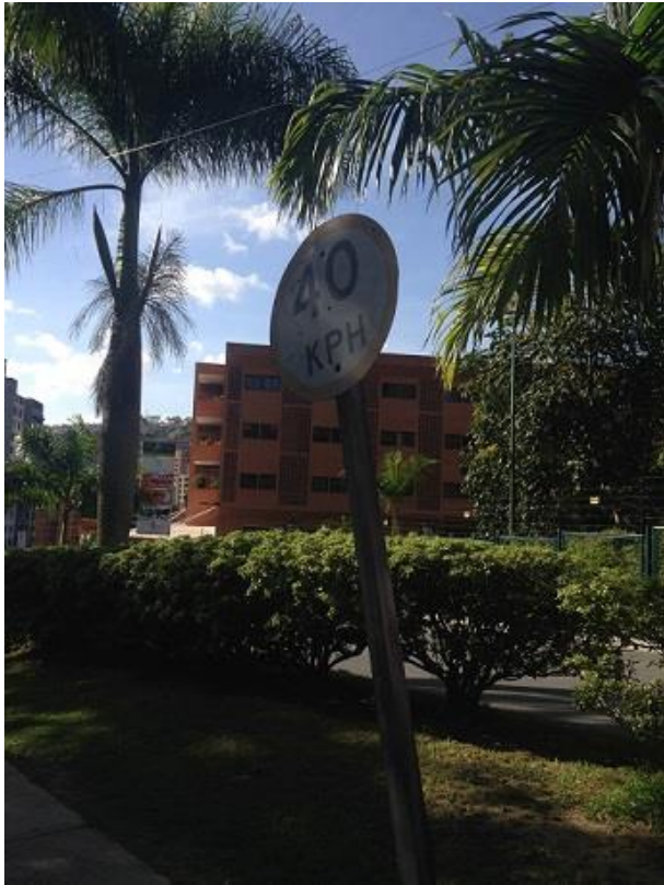
Foto 1: Señalización de velocidad caída, lo que la hace poco visible.
