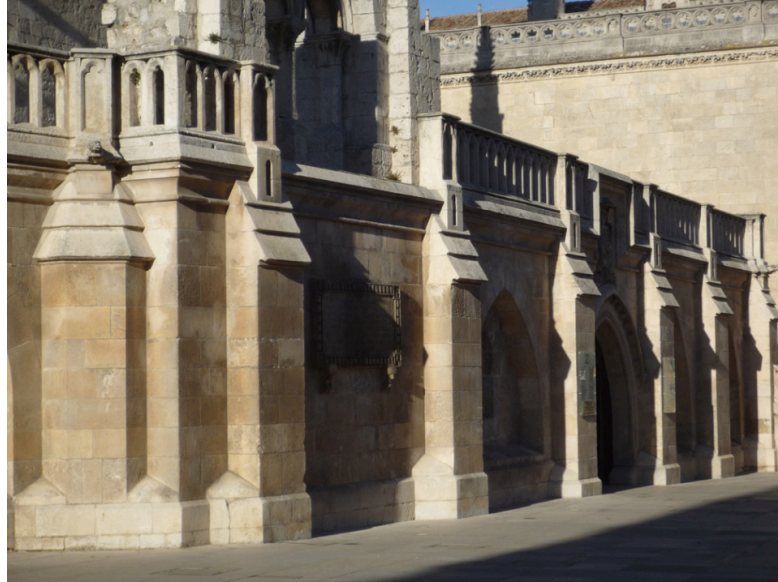
Figura 5. Contrafuerte. Fuente: Internet
