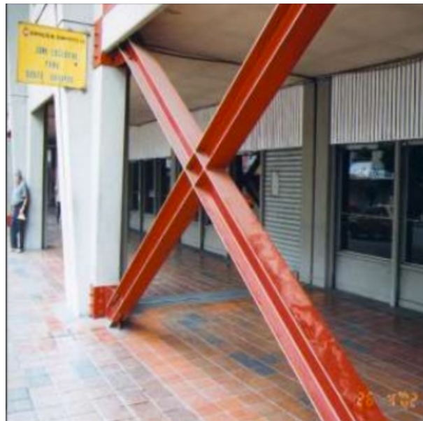
Figura 2 Arriostramiento. Fuente: Internet
