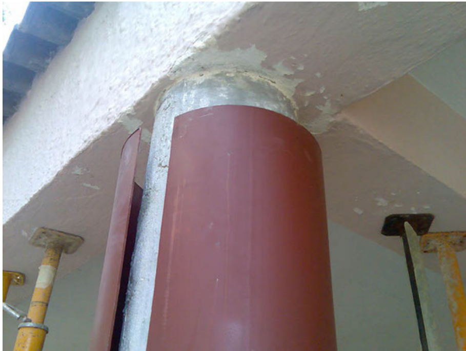
Figura 4. Encamisado de Acero. Fuente: Internet
