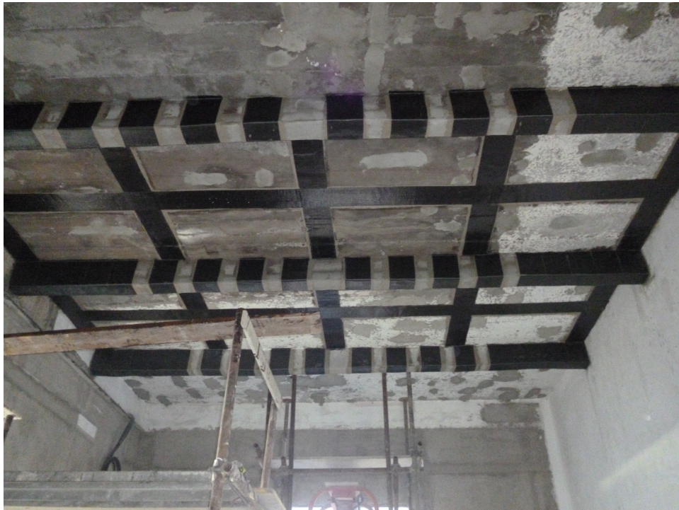
Figura 7. Refuerzo con Materiales FRP. Fuente: Internet
