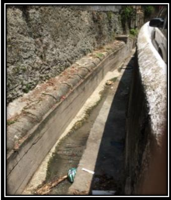
Canalización a la altura del Barrio Chapellín
