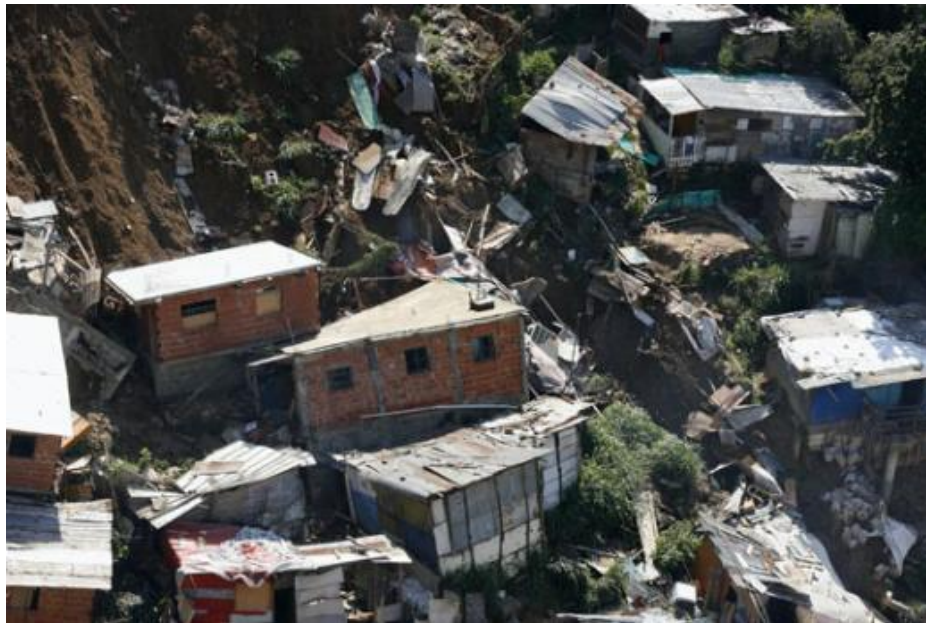
Figura 3-3: Colapso de ladera en barrio José Félix Ribas de Petare, Caracas ocurrido el 12 de septiembre del 2010. Fuente: El Nacional. Nancy Velasco.
