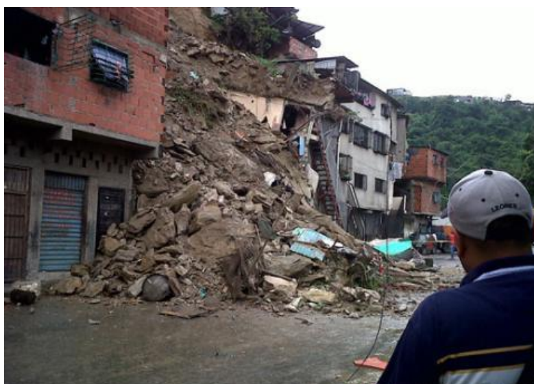
Figura 3-1: Deslizamiento de talud en la Avenida Guzmán Blanco de la Cota 905, Caracas ocurrido el 27 de noviembre del 2008. Fuente: El Universal. Alcázares, Venancio.
