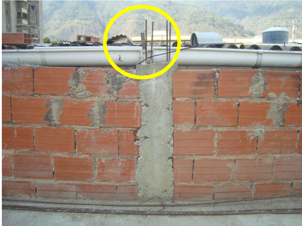
Figura 6-5: Azotea de vivienda ubicada en el barrio Chapellín Municipio Libertador. Se puede evidenciar la intención de continuidad de los pisos. (Fuente propia).
