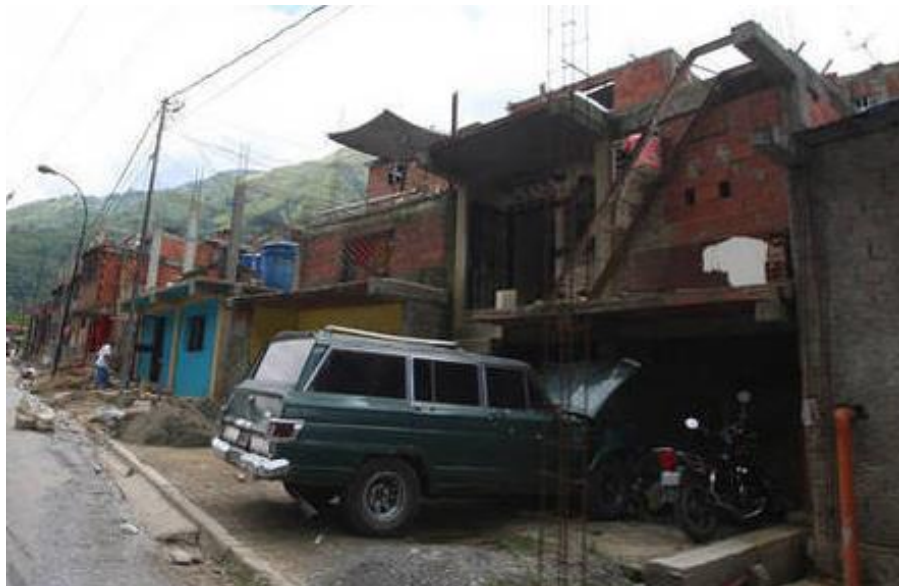
Figura 2-2: Taller mecánico en planta baja de vivienda en Barrio Brisas del Ávila. Fuente: El Universal. Foto: Alcázares, Venancio.
