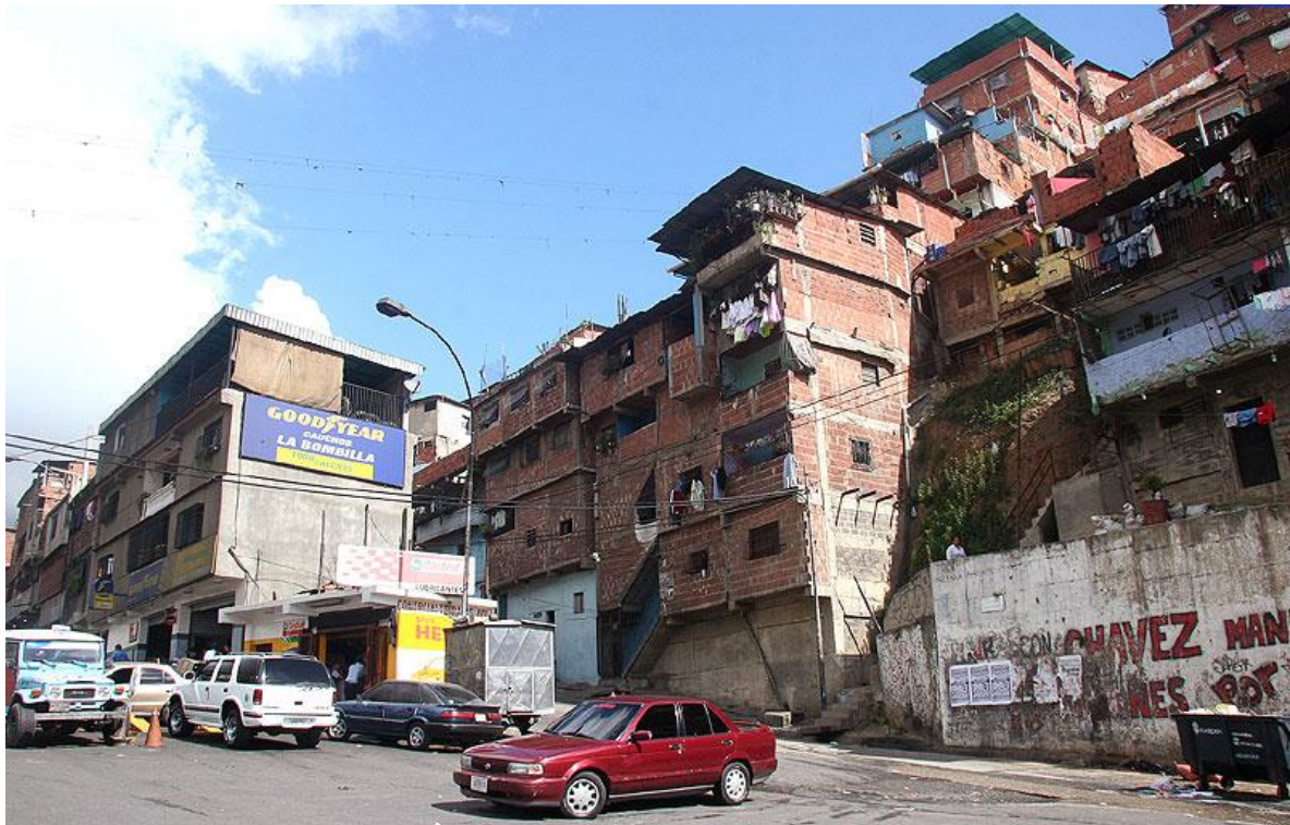
Figura 5-4: Viviendas colindantes de hasta 5 pisos de altura, con alturas de entrepiso distintas y sin juntas de separación. Barrio La Bombilla de Petare. (Foto: Eneko Etxebarrieta, 2008)
