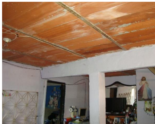
Figura 6-7: Pórtico en una sola dirección. Vivienda ubicada en el Barrio Chapellín, Municipio Libertador, Caracas. (Fuente: Propia).
