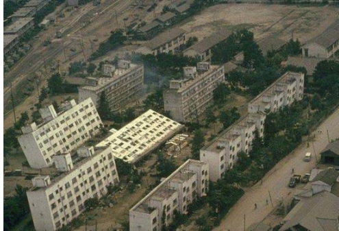
Gráfico 14. Efectos de licuefacción de suelos después del sismo de Niigata en 1964. Fuente: Alva (2013)
