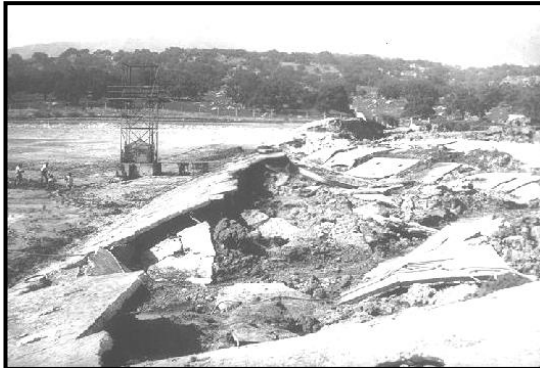
Gráfico 12. Falla de flujo en la Presa Sheffield provocado por el terremoto de Santa Bárbara en 1925. Fuente: Alva (2013)
