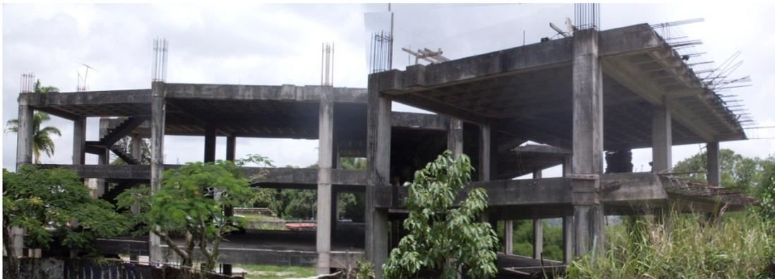
**(Arriba) Vista Sur de la Estructura.** Se observan rasgos de maltrato en las superficies del concreto producto de la intemperie. La estructura ya vaciada, sin embargo, parece mantenerse en buenas condiciones. Se puede apreciar arranques de acero ubicado en las columnas y placa para la terminación de la última losa del techo superior. El acero de los arranques está en muy malas condiciones.
