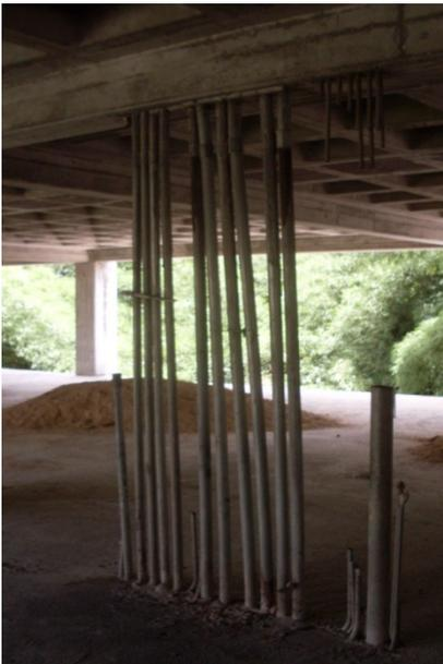
**(Izquierda, Abajo) Instalaciones Eléctricas.** Existen y se conservan en buen estado todas las tuberías eléctricas principales. Sin embargo, aún no tienen el cableado colocado.
