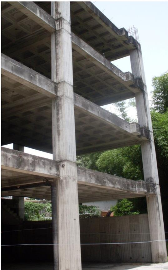
**(Izquierda, Abajo)- Vista Norte de la Estructura.** Se puede apreciar la verticalidad de la estructura. El sistema estructural es de losa tipo cúpula, con vigas altas sismo resistentes. A pesar del maltrato superficial del concreto producto de la intemperie, se observa que la resistencia y dureza aún se conserva.
