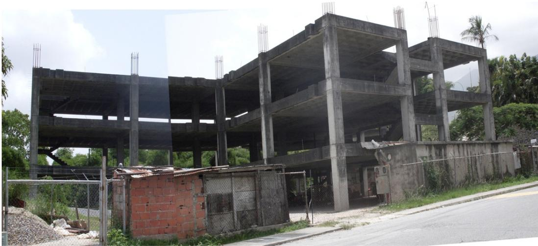
**(Arriba)- Vista Norte de la Estructura.** Igualmente de la otra parte de la estructura, se observan rasgos de maltrato en las superficies del concreto producto de la intemperie. Se puede apreciar igualmente los arranques del acero ubicado en las columnas y placa para la terminación de la última losa del techo superior. El acero de los arranques en ese sector de la estructura también está en muy malas condiciones.
