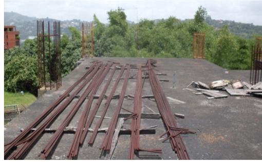
**(Izquierda y Arriba) Acero.** A pesar que ya están los arranques colocados para armar las columnas de la placa del techo, se observa un alto nivel de corrosión en el material, producto de la intemperie y del tiempo que ha pasado de su colocación hasta la fecha. Igualmente los materiales que descansan sobre la placa están bastante deteriorados.
