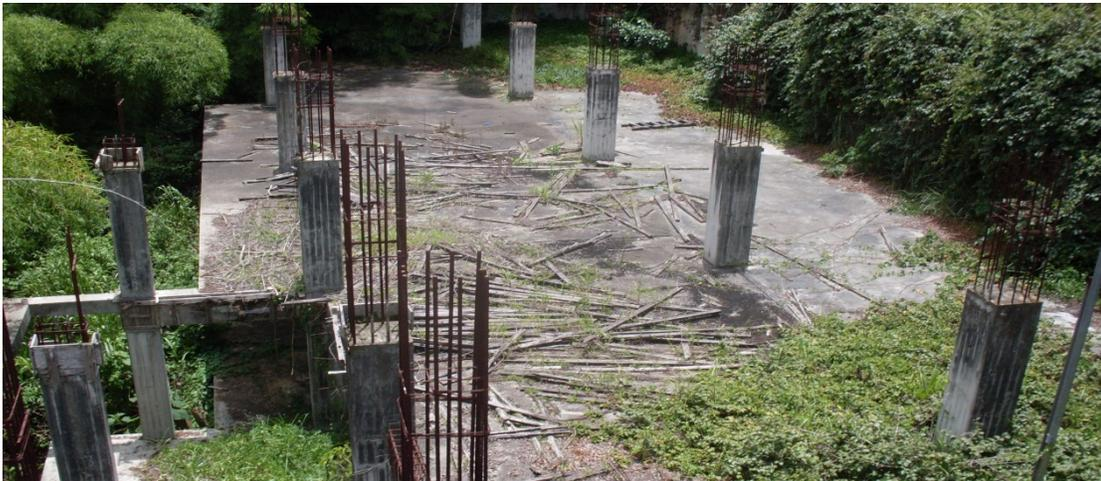
**(Arriba) Vista Estacionamiento.** En esta foto se puede observar el nivel de estacionamientos. Sobre este nivel aún resta por vaciar la placa de techo. Se observan las columnas ya vaciadas y los arranques correspondientes.
