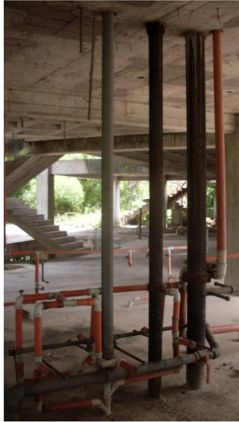
**(Arriba) Instalaciones Sanitarias.** Se pueden apreciar las instalaciones sanitarias de la escuela. Están colocados todas las tuberías y los bajantes y montantes respectivos de Aguas Blancas y Aguas Negras. Las instalaciones se encuentran en buen estado, debido a que están protegidas por las placas ya vaciadas.
