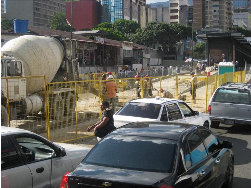
Trabajos en la vía por el BusCaracas genera congestión vehicular. Agosto 2011
