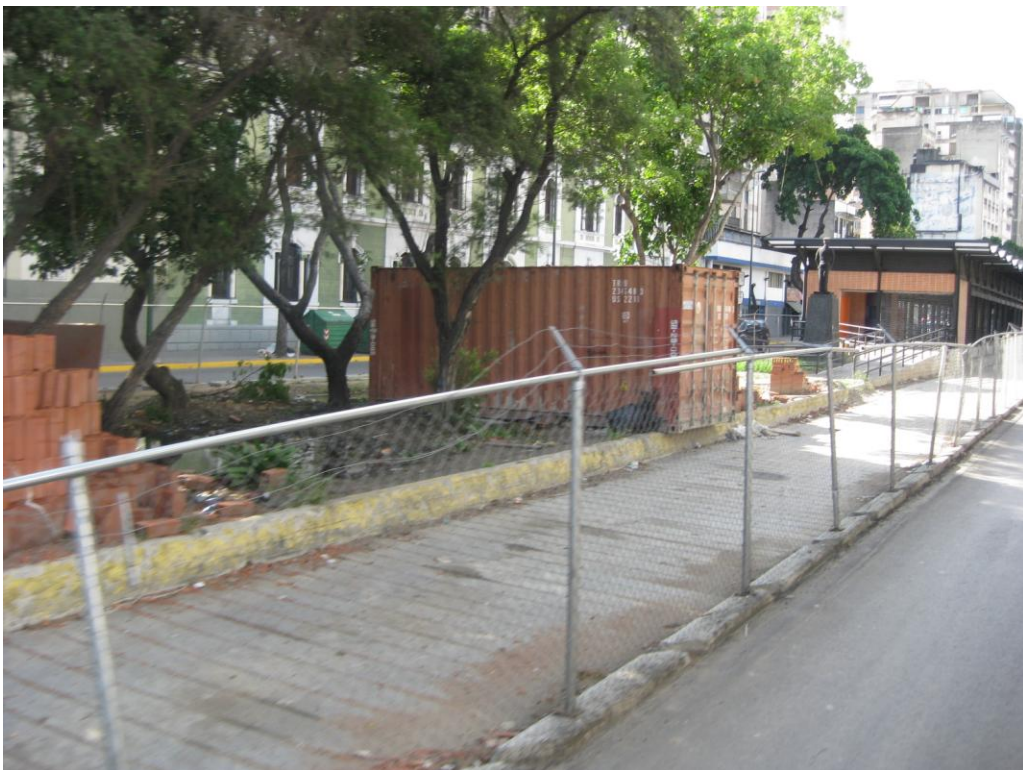
Estación por terminar en La Hoyada. Agosto 2011
