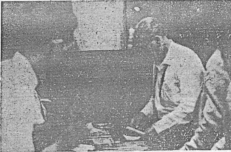
El Dr. Gustavo Marchado en persona atendió los primeros trabajos de reparación de las instalaciones, para poder sacar el tiraje de su periódico. — (Foto García).
