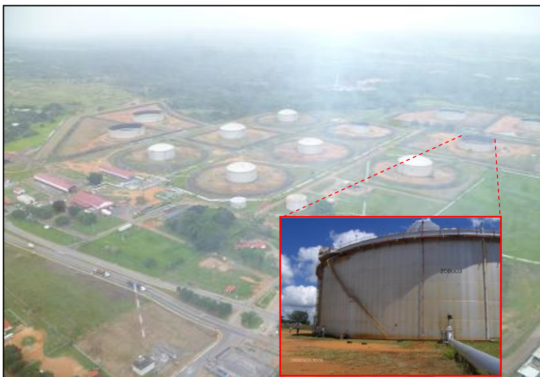
Figura 16. Vista general del tanque 200003.
