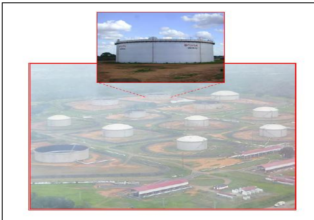
Figura 15. Vista general del tanque 200002.
