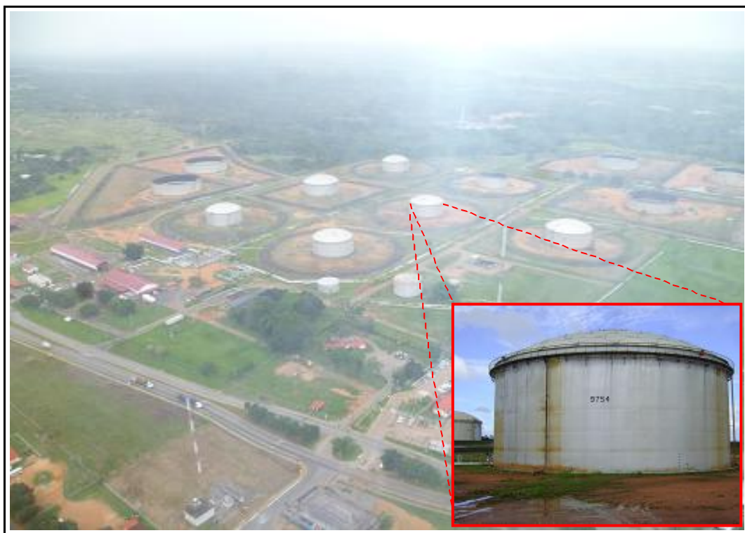
Figura 9. Vista general del tanque 9754.
