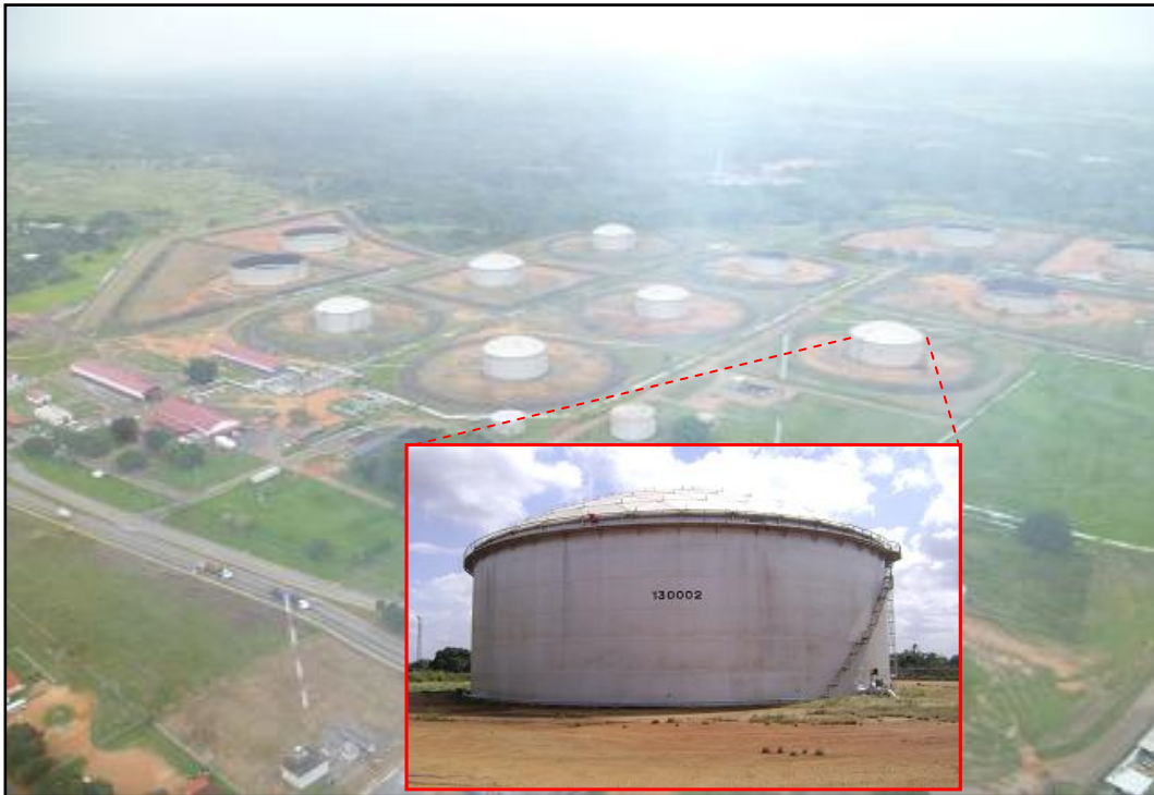
Figura 13. Vista general del tanque 130002.
