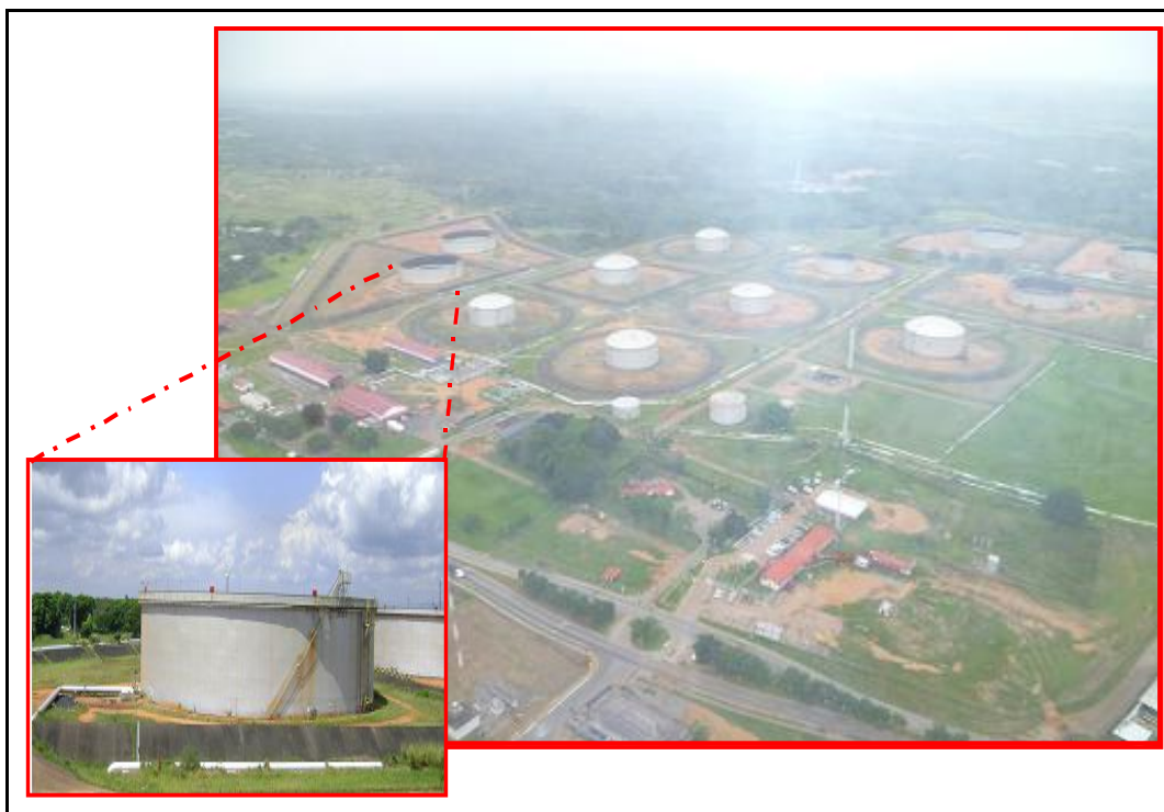
Figura 17. Vista general del tanque 250001.
