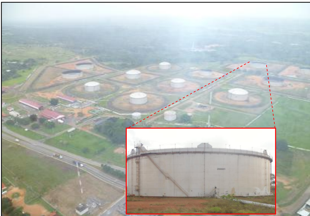
Figura 14. Vista general del tanque 200001.
