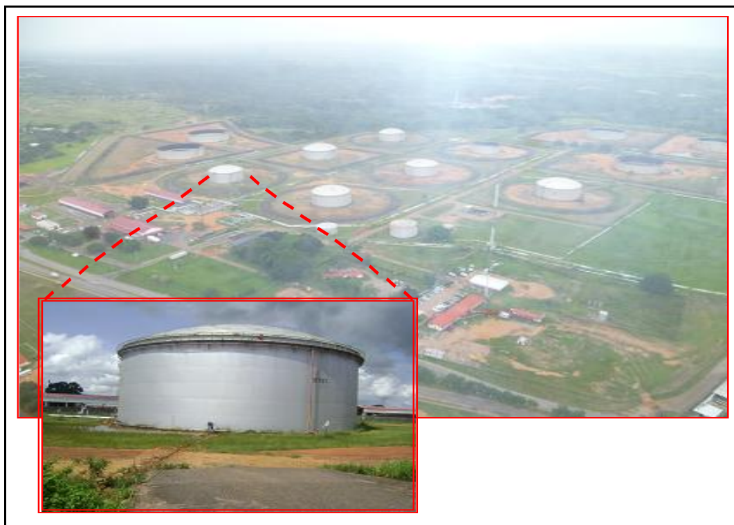
Figura 7. Vista general del tanque 9751.
