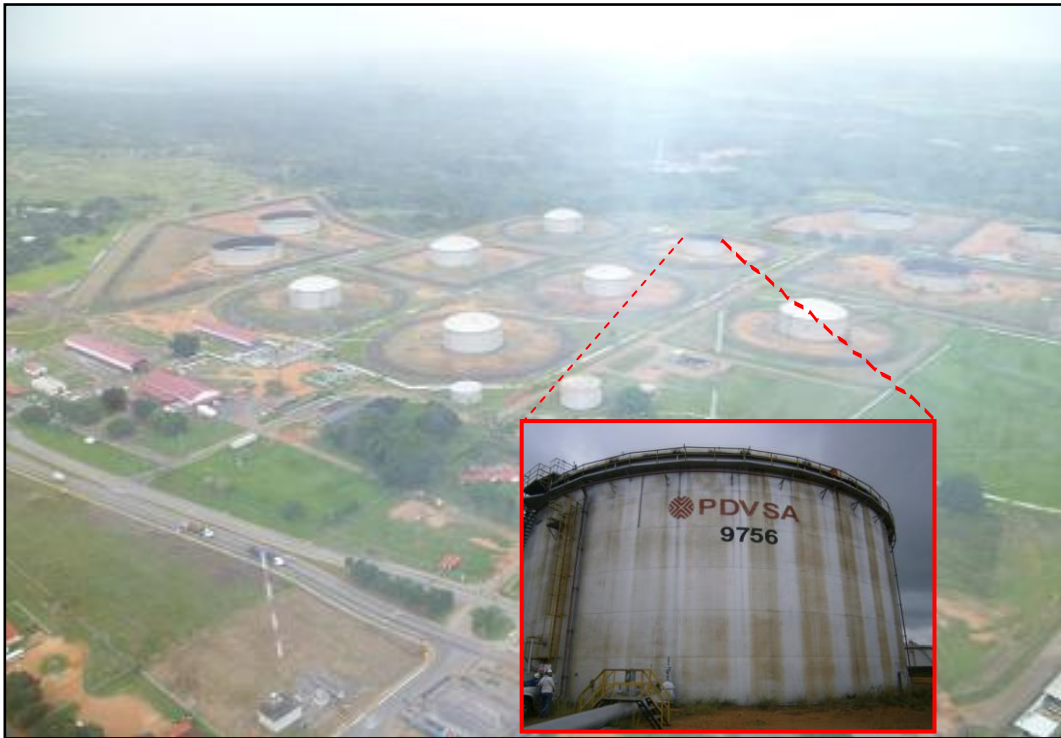
Figura 11. Vista general del tanque 9756.
