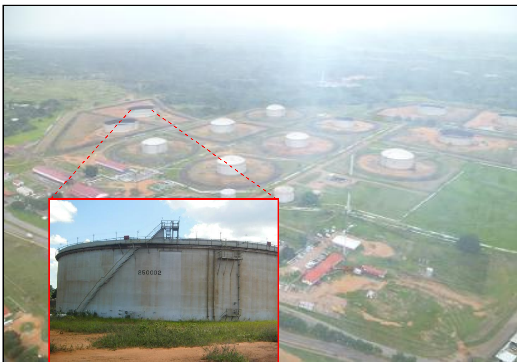
Figura 18. Vista general del tanque 250002.
