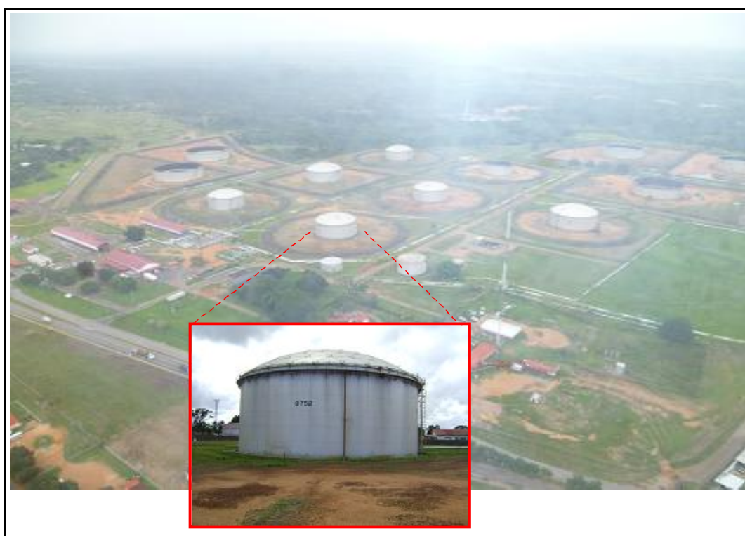
Figura 8. Vista general del tanque 9752.
