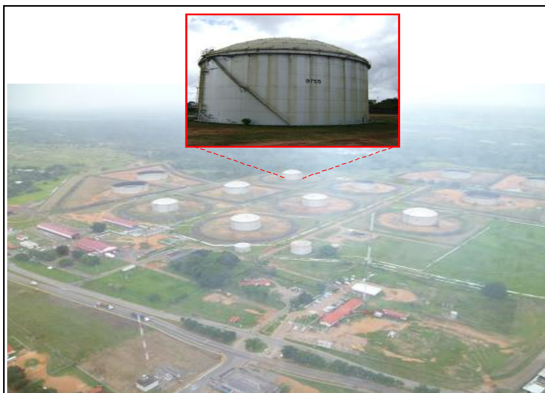
Figura 10. Vista general del tanque 9755.
