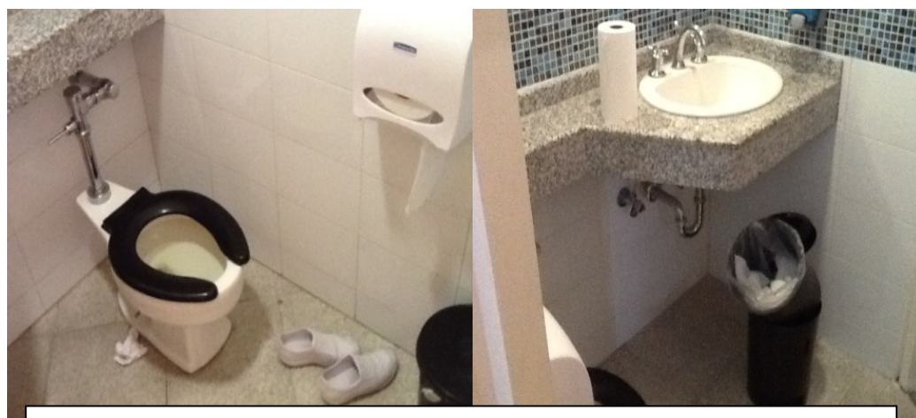
Baño del vestier del personal de enfermería, secretaría y personal auxiliar de mantenimiento.
