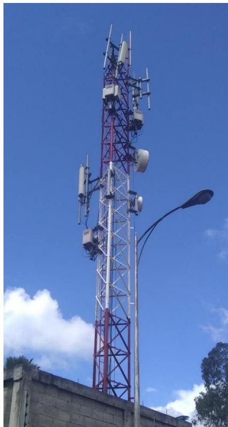
Figura 7. Torres Autoportadas de sección triangular constante Fuente: Foto propia
