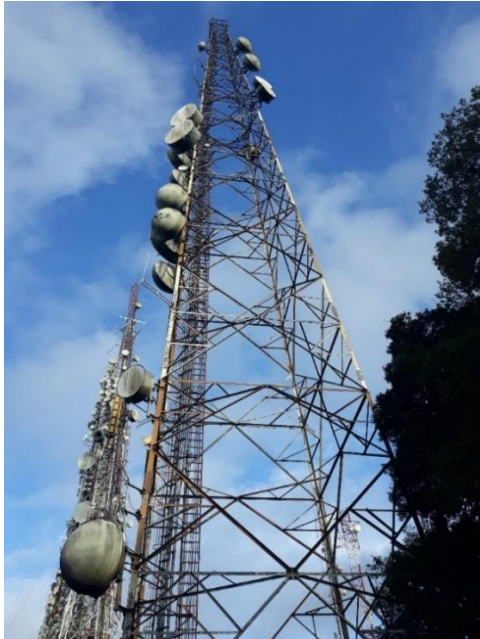
Figura 5. Torre Autoportada de sección variable Fuente: Foto propia
