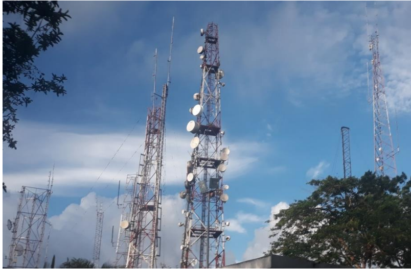
Figura 3. Torres Autoportadas Fuente: Foto propia
