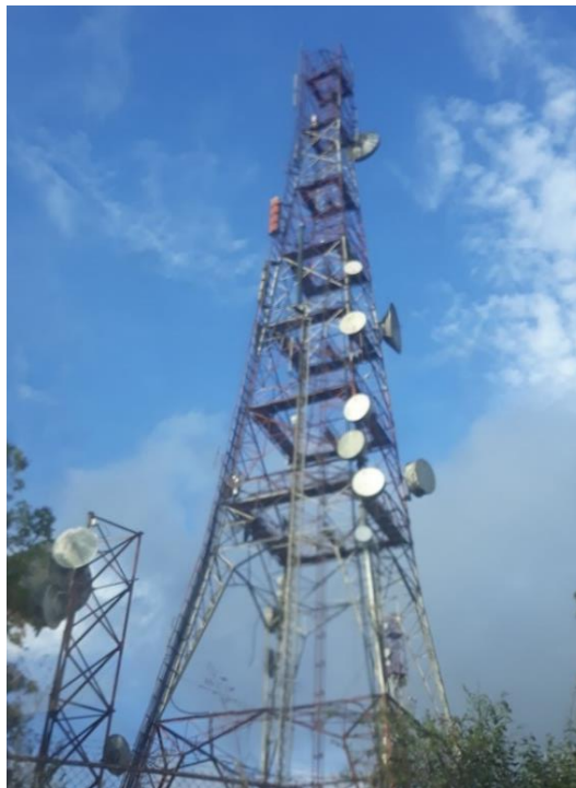
Figura 6. Torre Autoportada de sección variable Fuente: Foto propia
