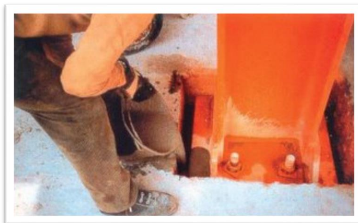
Figura 36. Grouting para anclaje y nivelación de estructuras metálicas. Fuente: Grouting: Tipos, Características y Requisitos para su colocación
