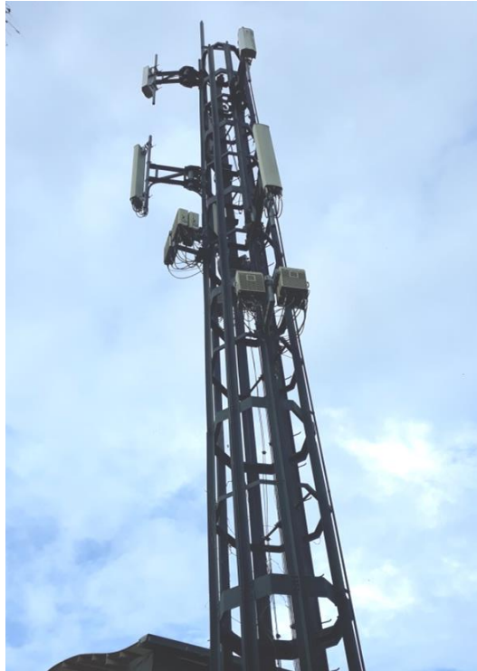
Figura 10. Torre autosoportada de sección ortogonal Fuente: Foto propia
