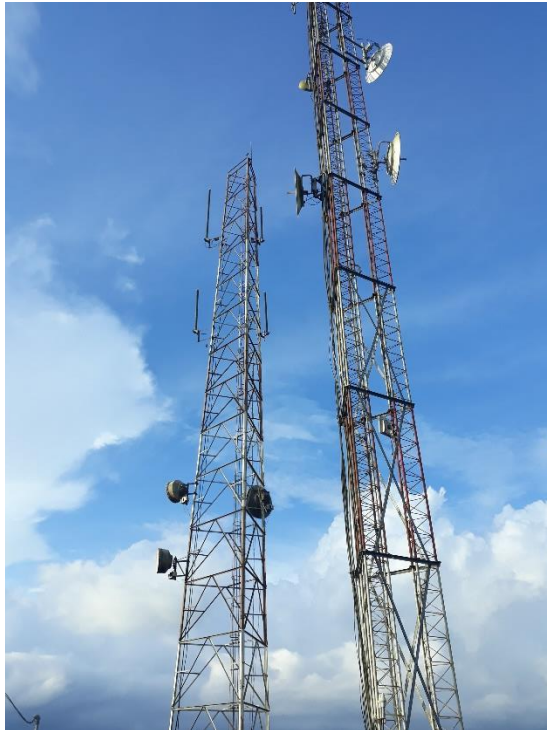
Figura 8. Torres Autoportadas de sección triangular variable Fuente: Foto propia
