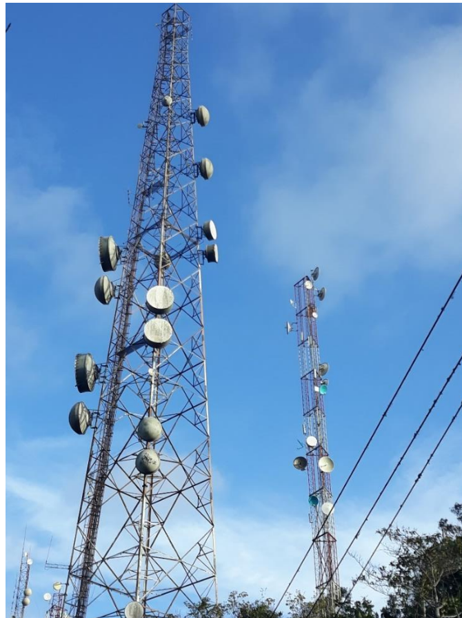
Figura 2. Torres Autoportadas Fuente: Foto propia
