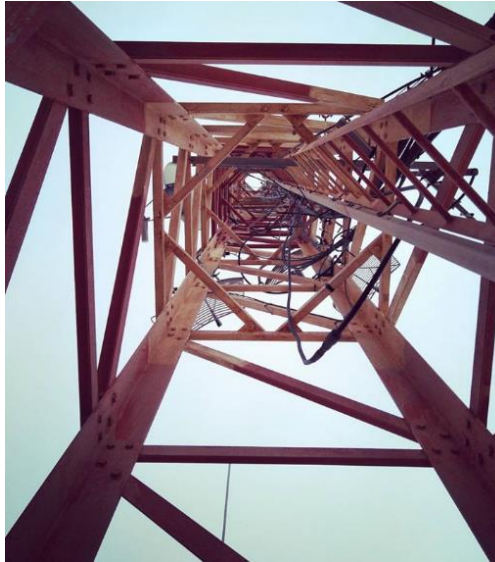
Figura 4. Torre Autoportada de sección cuadrada constante Fuente: Foto propia
