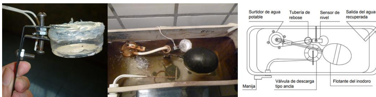
Figura 9. Sensor de nivel e instalación en el tanque del inodoro
