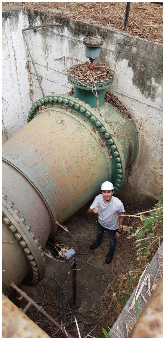
Anexo N°8. Tubo de Venturi a la salida de la planta potabilizadora “La Guairita”.
