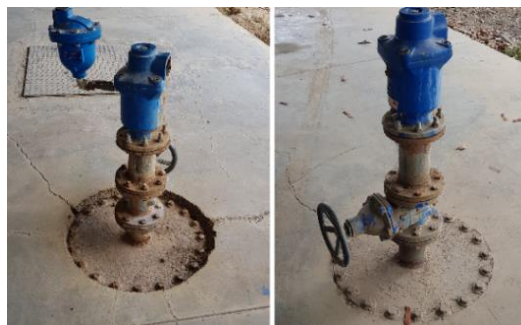
Figura N°23. Ventosas del múltiple de succión.
