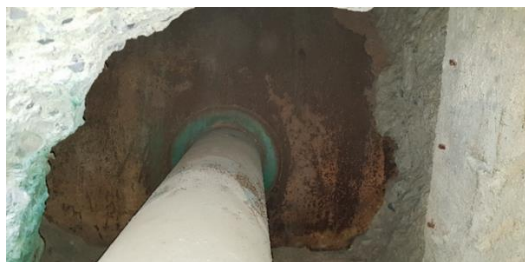
Figura N°22. Múltiple de succión de la estación en conexión con el sistema contra golpe de ariete del Grupo de bombeo Sur.
