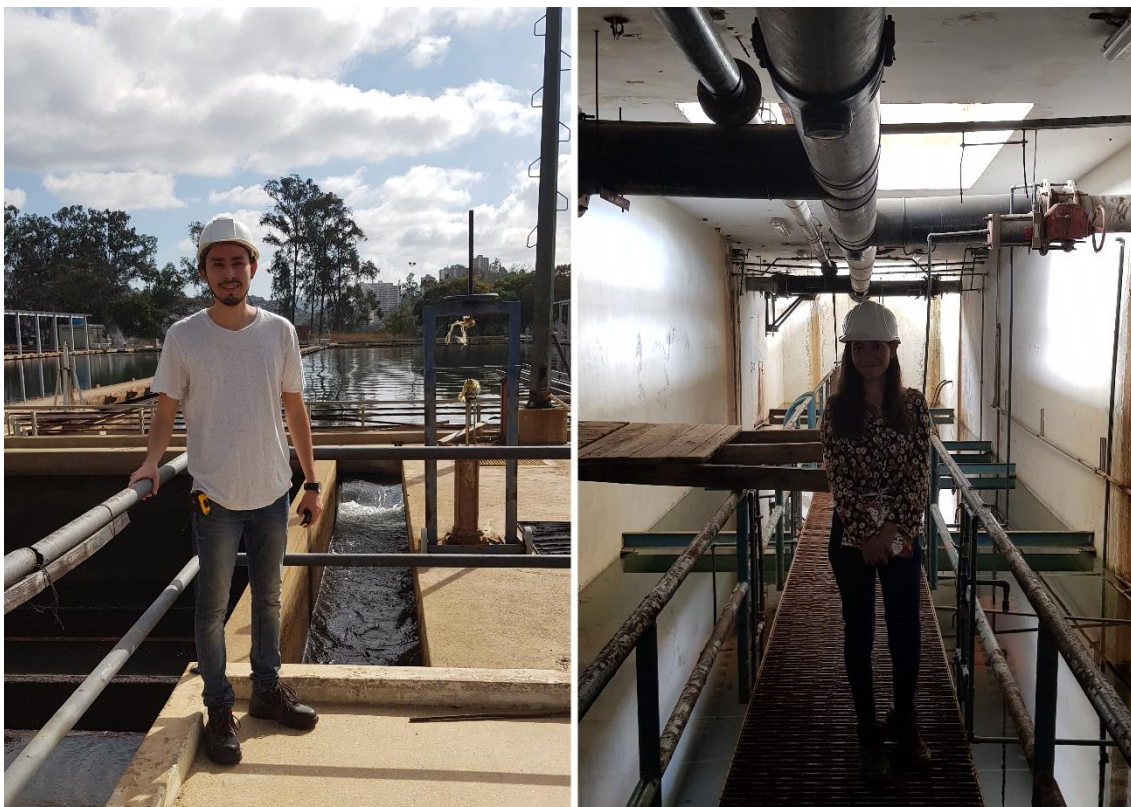
Anexo N°7. Reconocimiento de la planta de potabilización “La Guairita” aguas arriba de la estación de bombeo E/B 25.
