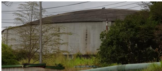
Figura N°21. Tanque compensador de la estación de bombeo.
