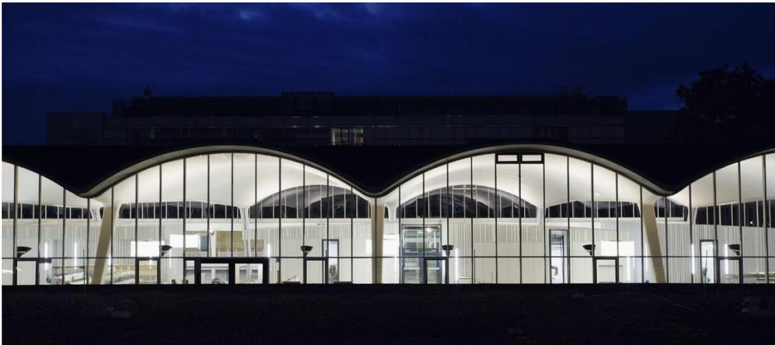
*Figura 22.* Instituto de hidrología, Technische Hochschule de Darmstadt, Alemania. Es posible cubrir grandes áreas por medio de conchas cilíndricas, asegurando una iluminación natural intensa. Los apoyos oblicuos aseguran la rigidez transversal de la estructura. Diseñado por Ernst Neufert & Alfred Mehmel, 1956. Fotografía de: autor desconocido, 2015. Obtenida de: <http://www.ramonabuxbaum.de>
