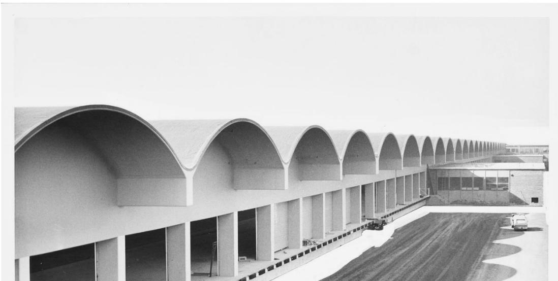
*Figura 51.* Terminal de carga Union Pacific, 30 cubiertas cilíndricas de concreto con vigas de bodred, 10 cm (4") de espesor. Los Ángeles, E.E.U.U. Fotografía de: Autor desconocido. Archivo de la Universidad del Sur de California. Obtenida de: <https://www.gettyimages.ae/detail/news-photo/largest-concrete-barrel-shell-job-in-california-is-the-30-news-photo/594893298?adppopup=true>
