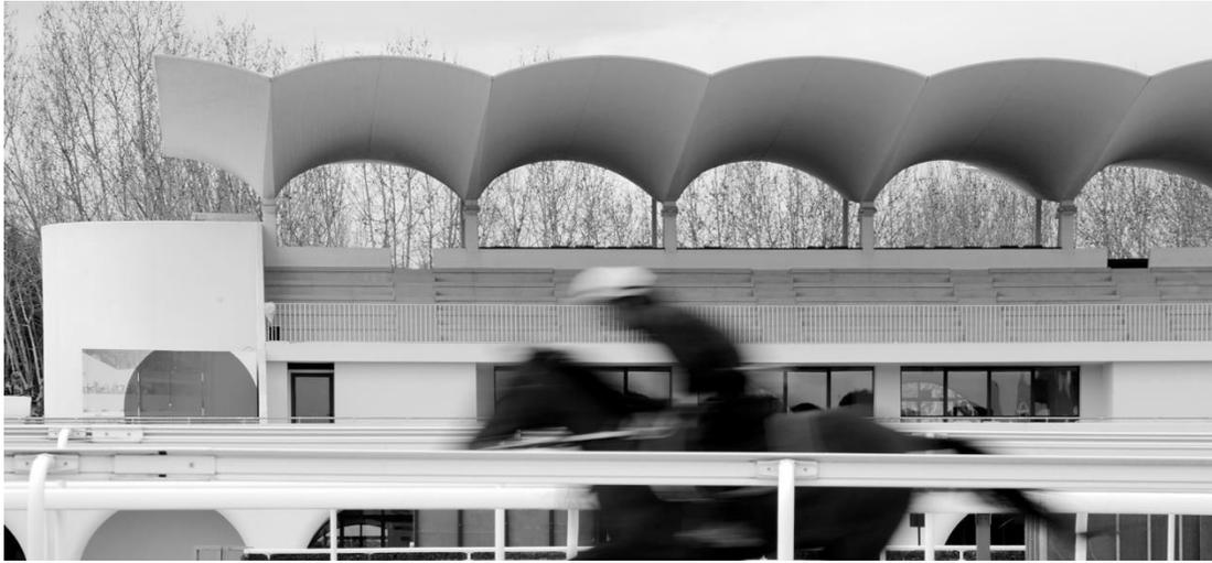
*Figura 23.* Cubierta de las tribunas del hipódromo de La Zarzuela, España. La cubierta la constituyen una serie de hiperboloides de una hoja. La construcción de las cubiertas se encuentra en voladizo de 12,57 m hacia la pista. El espesor de la concha es de 6,20 cm en el borde exterior y de 14,50 cm en la zona de los apoyos. Diseñada por Eduardo Torroja. Fotografía de Ana Amado, 2016. Obtenida de: <https://www.plataformaarquitectura.cl/>
