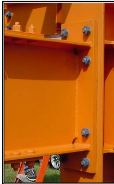
*Figura 12: **Conexión rígida.** Fuente: Soto, H. (2005).*
