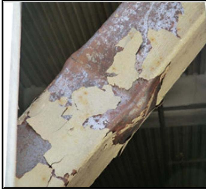
*Figura 26: Pandeo local en el extremo de una diagonal. Fuente: Crisafulli, F. (2014).*
