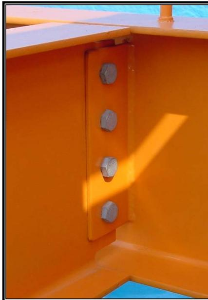
*Figura 14: **Conexión flexible.** Fuente: Soto, H. (2005).*
