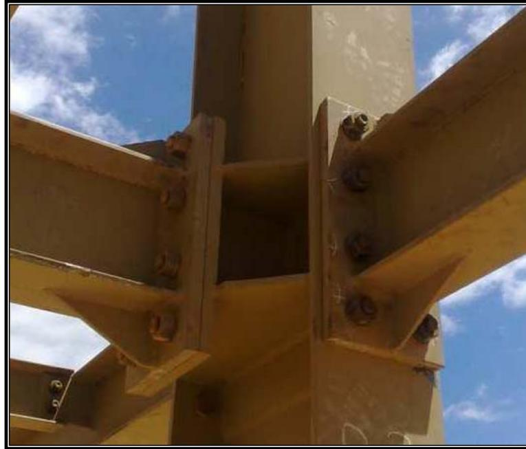
**Figura 32: Conexión Plancha Extrema en el ala y el alma de la columna.**
