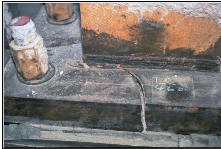
**Figura 22: Fractura en una plancha de base de columna de una estructura de pórtico arriostrado. Fuente: Crisafulli, F. (2014).**
