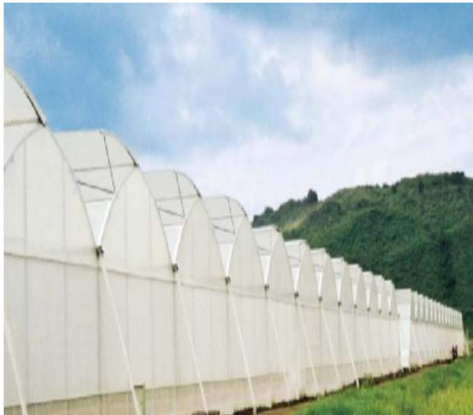
Figura 11. Casas de Cultivo mostrando Sistema de Ventilación.
