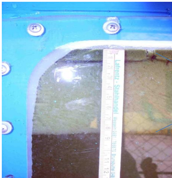
Imagen N° 15 Nata de flotación acumulada por efecto del empuje por aire en el tanque de flotación.
