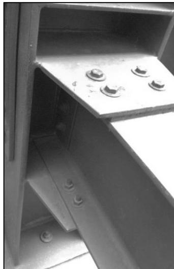
*Figura 11. **Conexión rígida***
