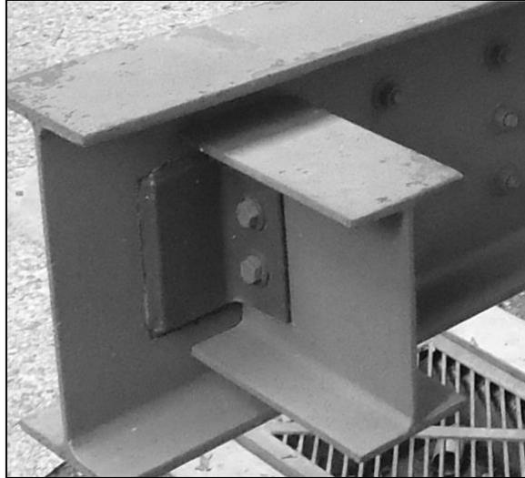
*Figura 10. **Conexión simple (combinación de Soldadura y pernos)***
