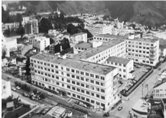
**Figura 10. Hospital de Caldas, Colombia, presenta irregularidad en planta.** Tomada de "Fundamentos para la Mitigación de Desastres en Establecimientos de Salud", OPS, 2004, p. 45.
