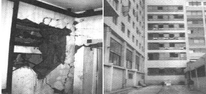
**Figura 9. Daños no estructurales en el hospital de Antofagasta, Chile, debidos al sismo del 31 de julio de 1995.** Tomada de “Lecciones Aprendidas en América Latina en Mitigación de Desastres en Instalaciones de la Salud”, OPS, 1997, p. 46-47.
