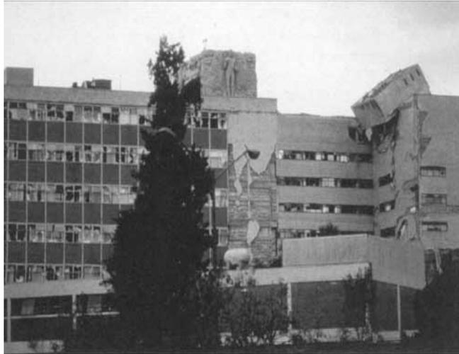
**Figura 18. Concentraciones de masa en altura, tales como tanques de agua, aumentan la vulnerabilidad estructural.** Tomada de “Fundamentos para la Mitigación de Desastres en Establecimientos de Salud”, OPS, 2004, p. 47.
