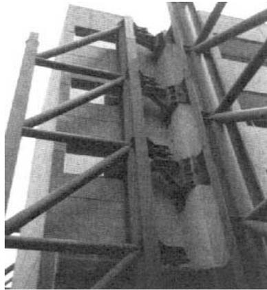
**Figura 21. Hospital de Cardiología del IMSS, México D.F. reforzamiento a base de disipadores de energía.** Tomada de “Lecciones Aprendidas en América Latina en Mitigación de Desastres en Instalaciones de la Salud”, OPS, 1997, p. 98.
