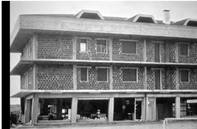
**Figura 19. Edificio con irregularidad tipo “piso flexible.** Tomada de “Fundamentos para la Mitigación de Desastres en Establecimientos de Salud”, OPS, 2004, p. 49.
