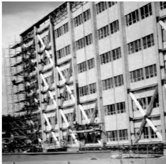
**Figura 20. Pórticos de acero como refuerzo con diagonales anclados fuertemente a los diafragmas.** Tomada de “Fundamentos para la Mitigación de Desastres en Establecimientos de Salud”, OPS, 2004, p. 70.
