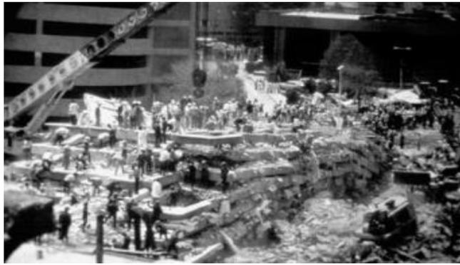
**Figura 12. Colapso total del Hospital Benito Juárez. México.** Tomada de “Fundamentos para la Mitigación de Desastres en Establecimientos de Salud”, OPS, 2004, p. 16.
