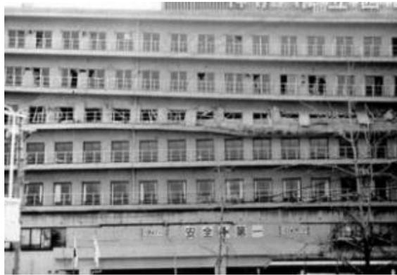
**Figura 8. Colapso del 5to piso del Hospital Municipal. Kobe, Japón.** Tomada de “Fundamentos para la Mitigación de Desastres en Establecimientos de Salud”, OPS, 2004, p. 17.
