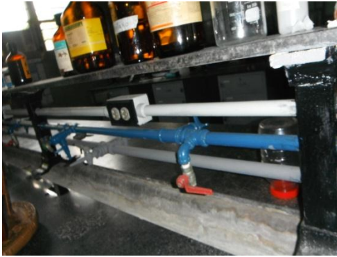
Tuberías no identificadas con el color adecuado
