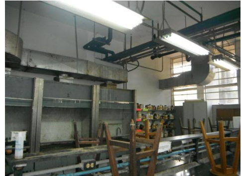
Tuberías no identificadas con el color adecuado
