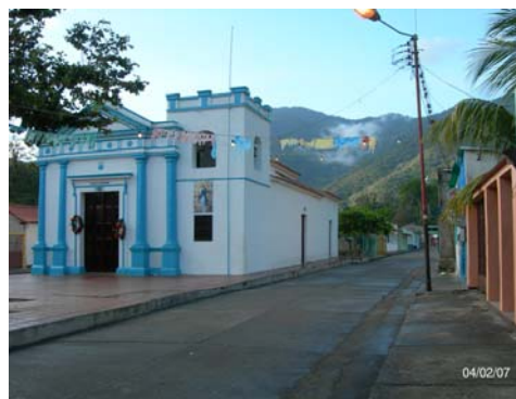
Iglesia de Cuyagua. Gómez, 2007
