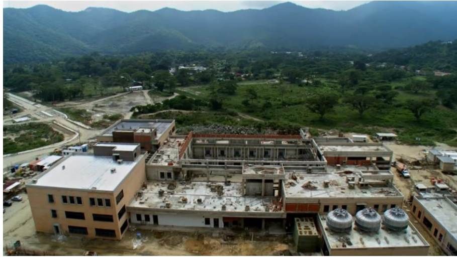
Figura n° 8. Construcción del CIDE Fuente: ABAE (2018)
