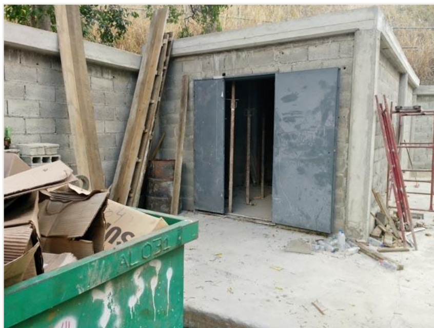
Anexo 11: Cuarto frio en construcción
