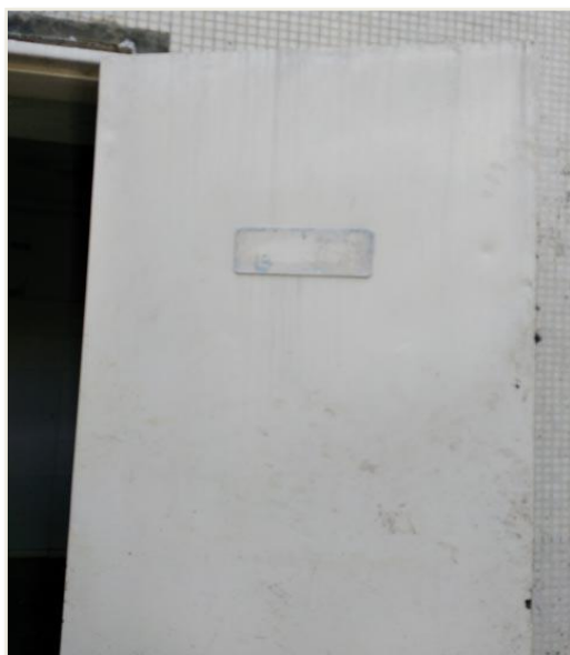
Anexo 13: Señalización sin distinción en la E.T.4
