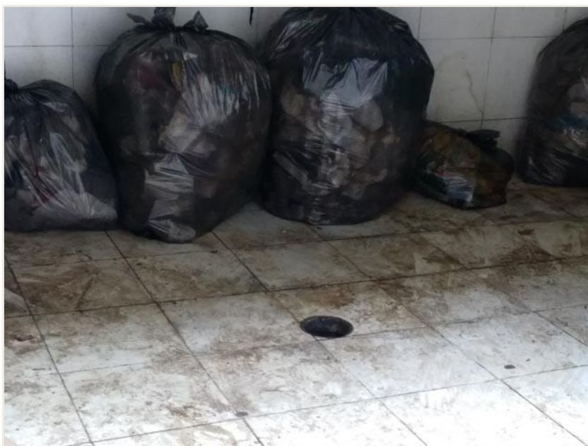
Anexo 14: E.T. sin mantenimiento
