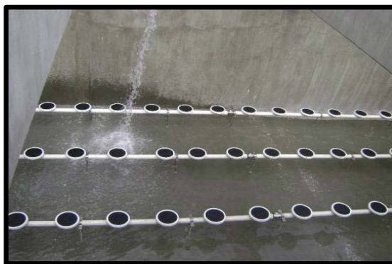
Figura 6 Difusores de burbujas finas. Nota. Recuperado de: QUIMINET.COM (2013).
