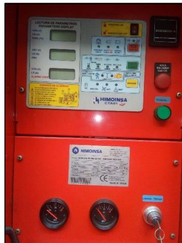
*Ilustración 34: Panel de control de planta eléctrica*
