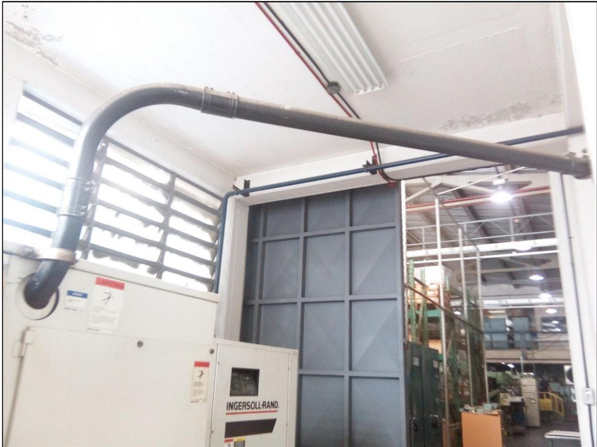
*Ilustración 36: Instalación de tubería desde cuarto de compresores*
