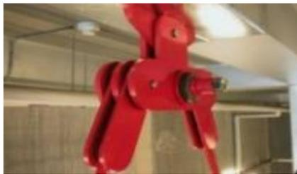
Figura 13. Disipador de fricción por golillas
