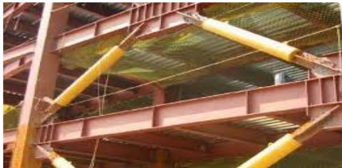
Figura 7 Disipador tipo Unbonded Braces
