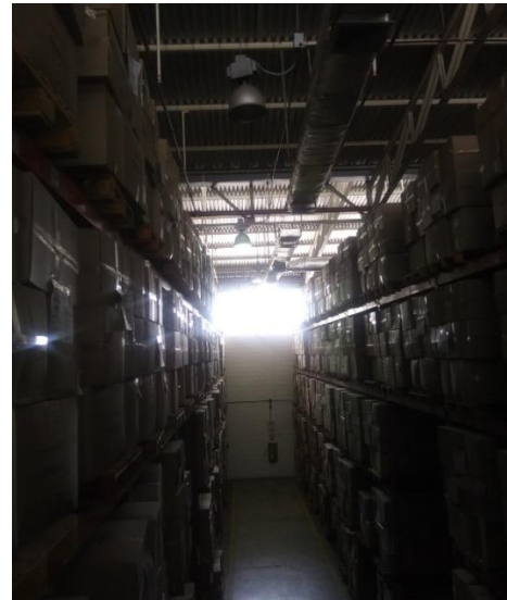
Figura 15: Iluminación deficiente en el centro de distribución
