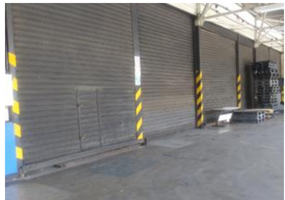
Figura 16: Áreas de recepción y despacho sin señalización y con paletas mal ubicadas
