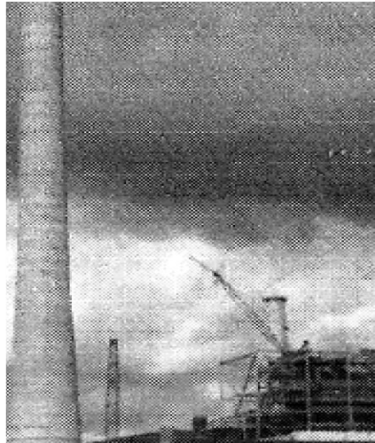
Figura 2. Chimenea de Concreto Armado. Fuente: Barreno, R (Enero, 2014).
