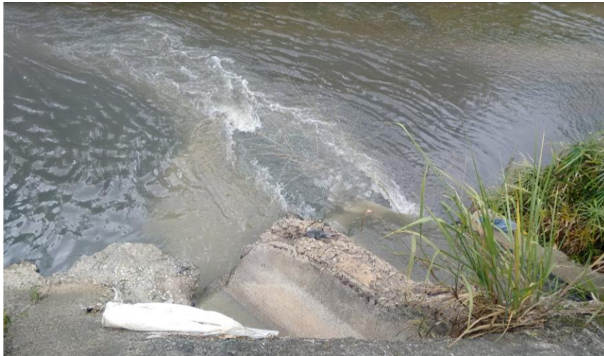
Ilustración 13. Punto de descarga de agua residual. Sección de cajón de doble celda. Sector I Fuente: Propia
