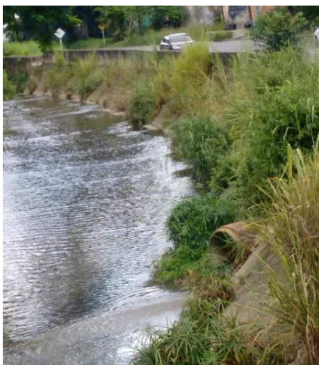
Ilustración 12. Punto de descarga de agua residual. Sección tubular. Zona Urb. Coracrevi Sector I Fuente: Propia
