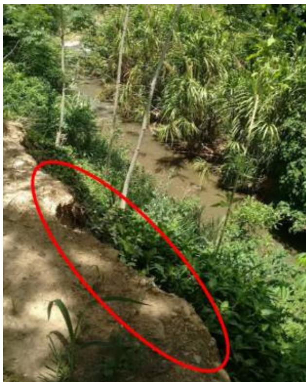
Ilustración 22. Deslizamiento del talud de la margen izquierda (1). Zona, parque la trinidad. Sector IV Fuente: Propia
