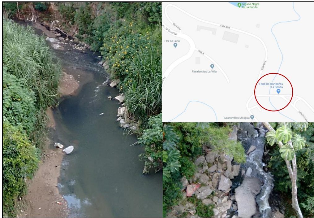
Ilustración 16. Vista de la quebrada aguas arriba y aguas abajo desde el puente La Bonita. Sector II Fuente: Propia
