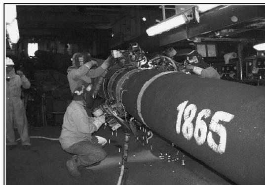
**Figura 2.** Soldadura de tubería submarina.
