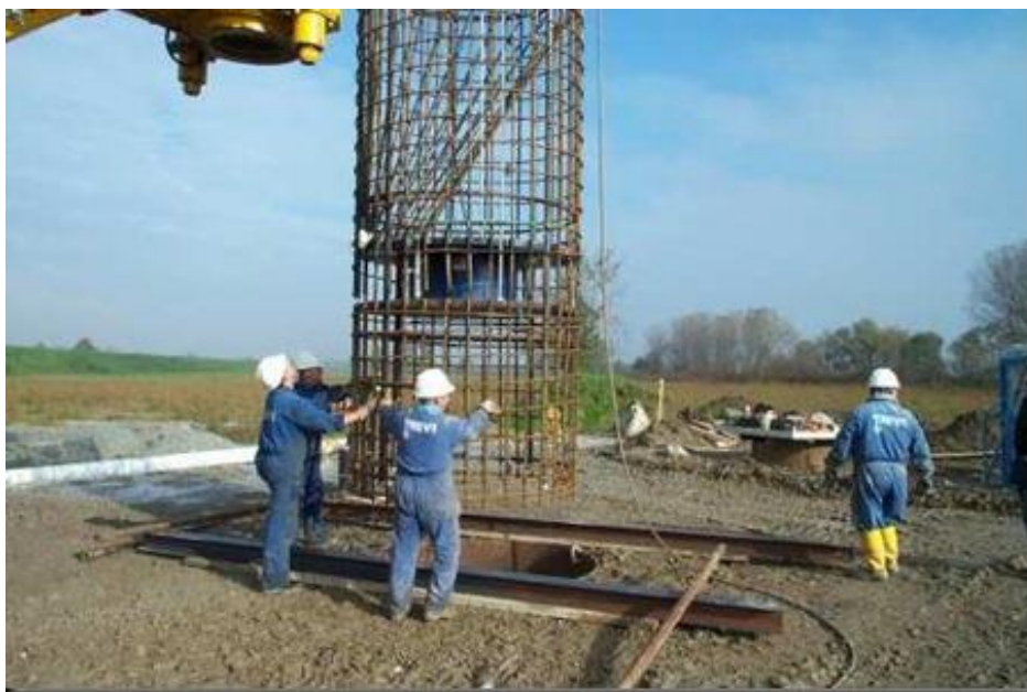
Figura 23. Colocación de cajuela de acero.
