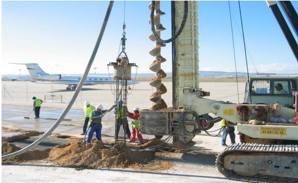
Figura 24. Colocación de cajuela de acero con rodillos de restricción.
