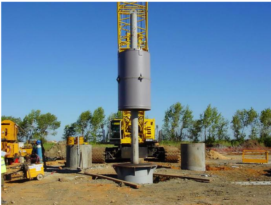
Figura 31. Prueba dinámica para estimar la capacidad portante.
