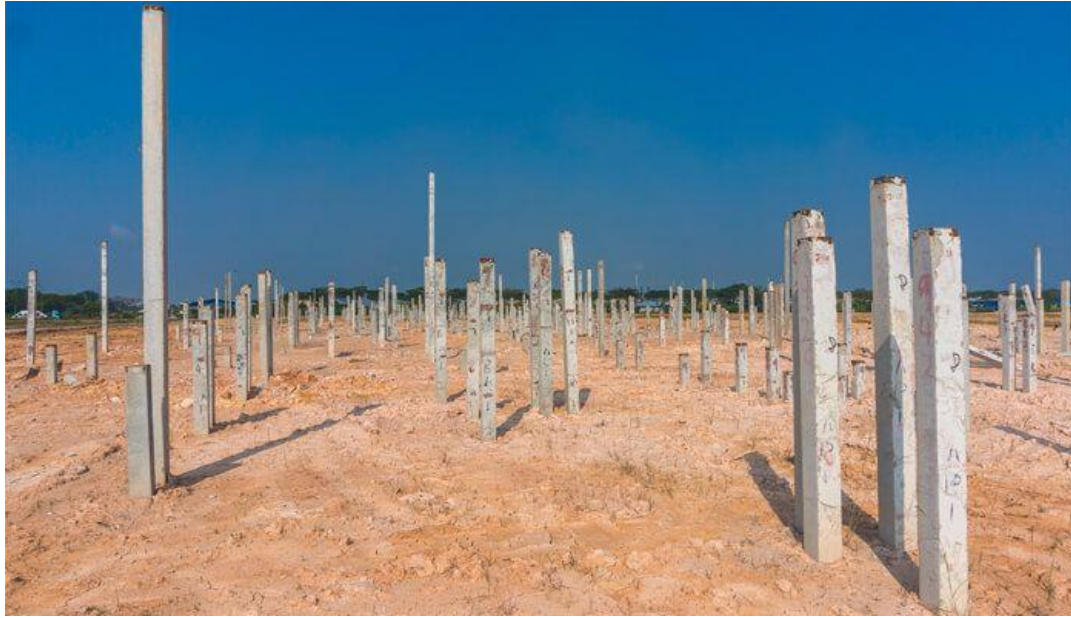
Figura 11. Lote de pilotes hincados
