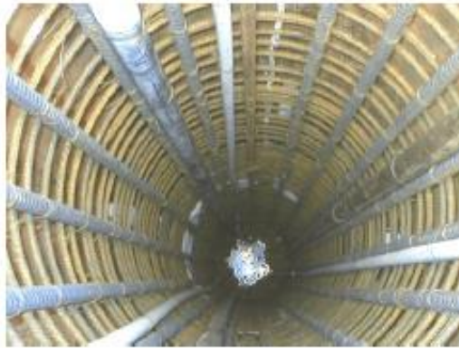
Figura 22. Hoyo completamente vertical ya armado.
