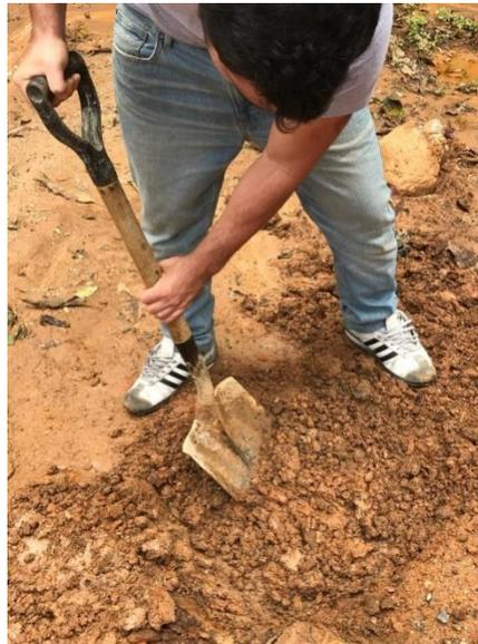
Figura 39. Escarificación del terreno
