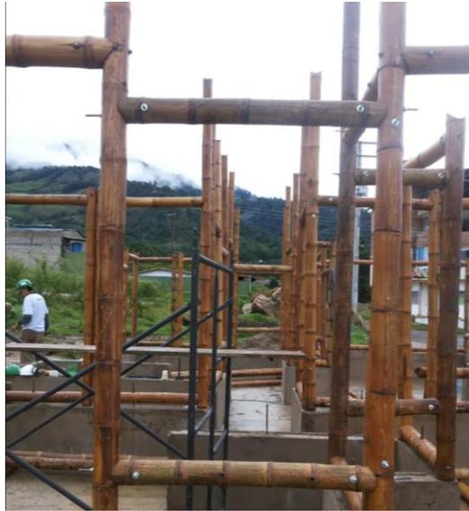
Figura 33. Colocación de rigidizadores
