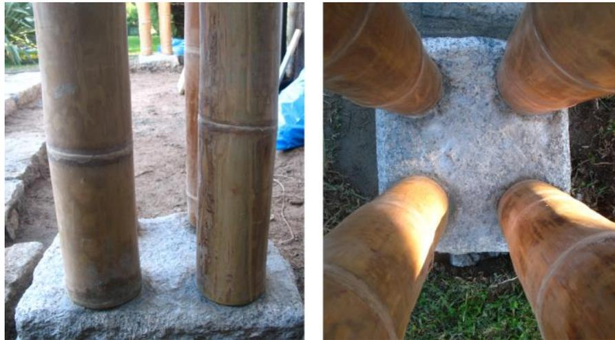
Figura 26. Colocación de columnas al pedestal.
