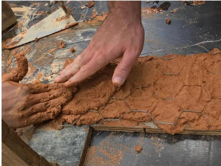
Figura 54. Colocación de segunda capa de bahareque
