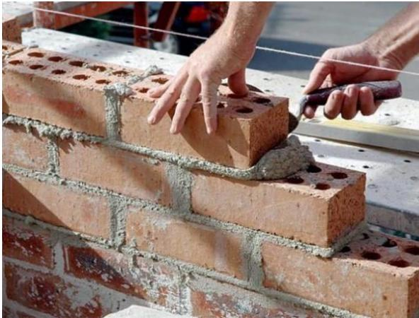
Figura 35. Colocación de bloques de arcilla
