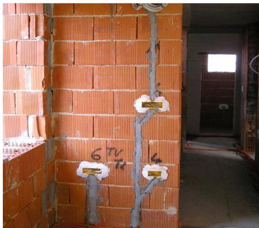
Figura 36. Colocación de instalaciones eléctricas
