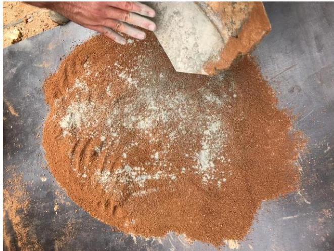
Figura 47. Agregado del cemento
