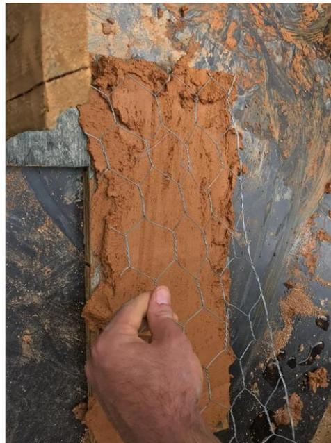
Figura 53. Colocación de malla
