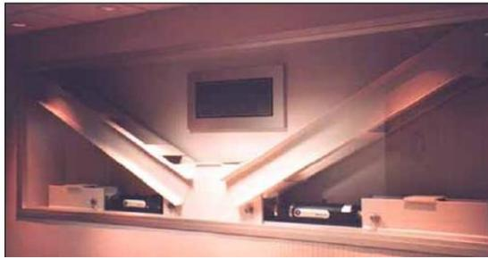
Figura 23. Disposición Chevron invertida (Pacific Bell 911, California, USA). Fuente FEMA 273-274.
