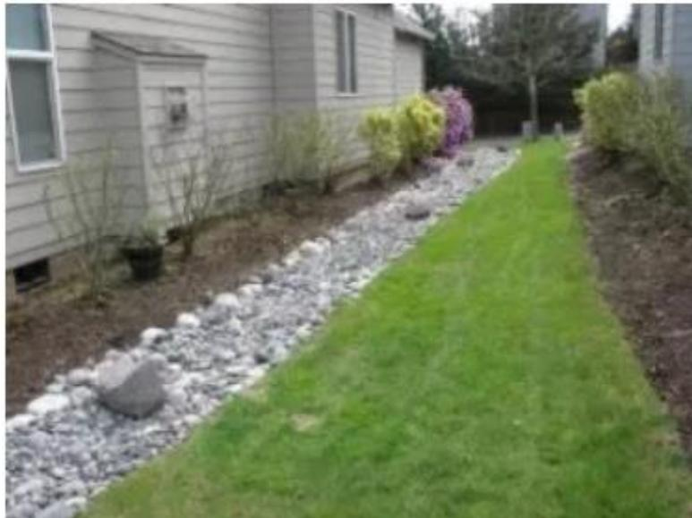
Figura N°17. Ejemplo de dren filtrante. Fuente: Abellán, 2017
