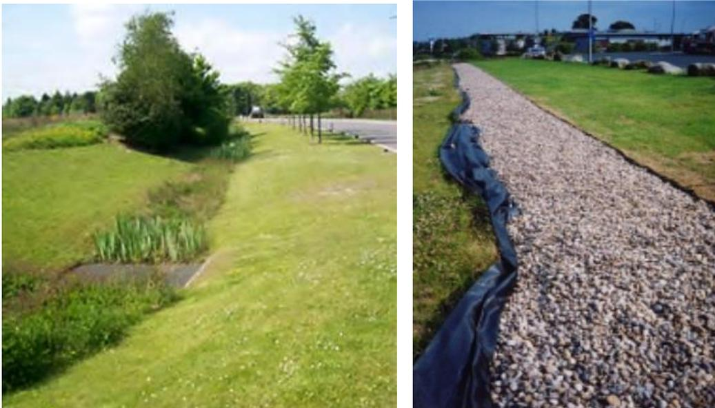
Figura N°16. Ejemplos de franjas filtrantes. Fuente: Ballester-Olmos, 2013 y Susdrain, 2018
