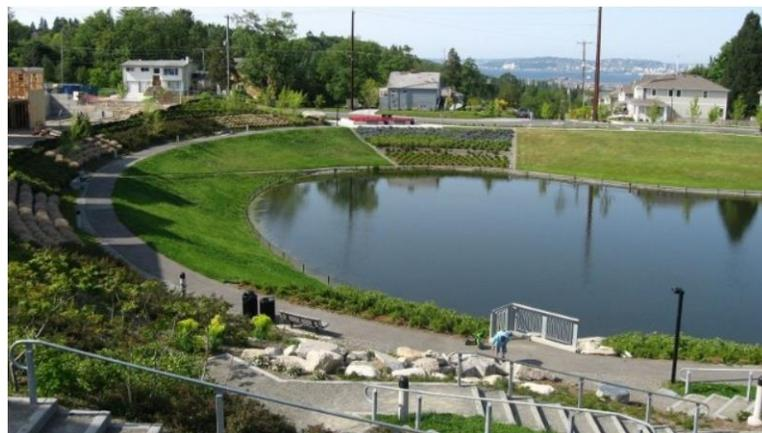
Figura N°20. Ejemplo de un estanque de retención. Fuente: Abellán,2017
