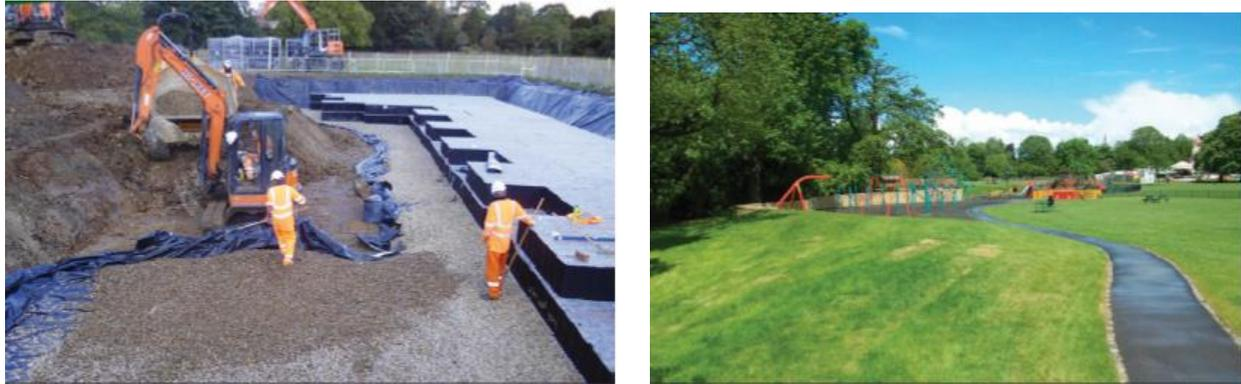
Figura N°28. Instalación de los tanques geocelulares y vista del parque en Dulwich. Fuente: Kissi y Jessop (2015)
