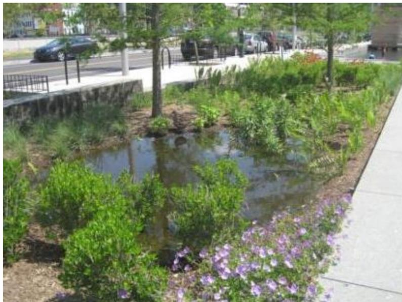
Figura N°19. Ejemplo de área de bioretención. Fuente: (Villalonga,2017 y Abellán,2017)
