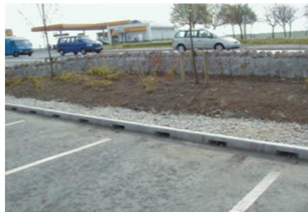
Figura N°14. Ejemplos de zanjas de infiltración. Fuente: Ballester-Olmos,2013 y Susdrain, 2018
