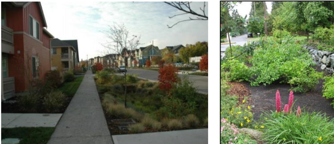
*Figura N°26. Calles permeables y sistemas de bioretención de High Point, Seattle. Fuente: Seattle Public Utilities, 2008*
