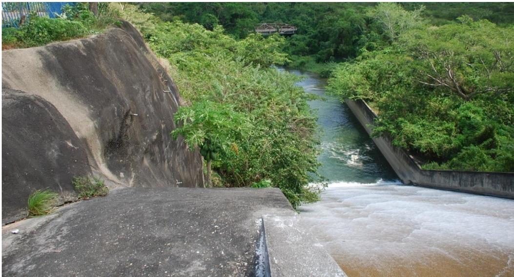
**Figura 11 Pozo disipador tipo USBR II**
