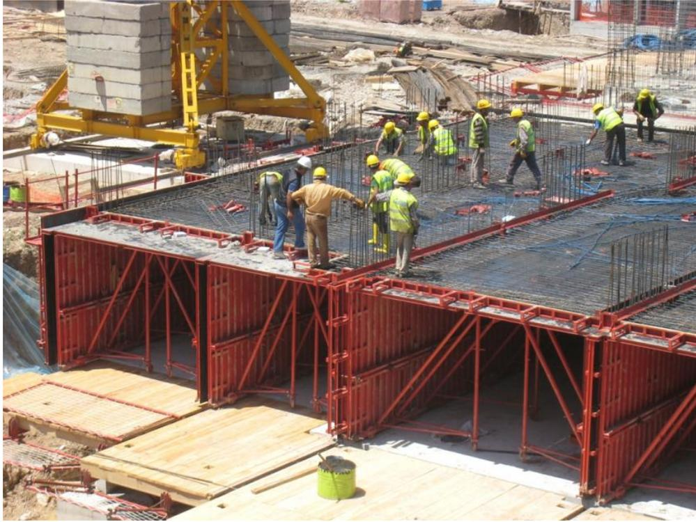
**Figura 25. Sistema tipo túnel (Fuente: Cortesía Mesa Formwork USA)**
