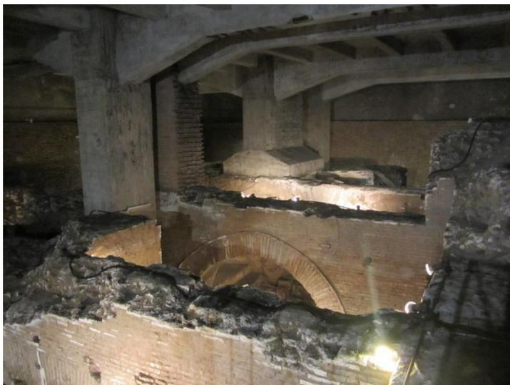
**Figura III-6:Columnas apoyadas sobre los muros del Mitreo del Circo Máximo.**
