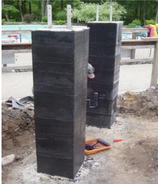
**Figura 1.1** Columnas reforzadas con CFRP
